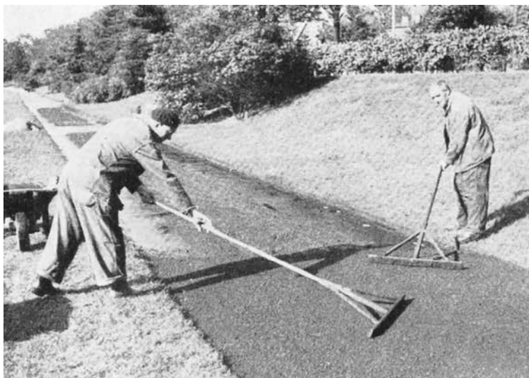
I 50'erne blev asfalt også almindeligt i anlægsgartneriet. Her udlægges der pulverasfalt på en gangsti en park. Fra Georg Boyes 'Anlægsgartneri' fra 1959. Foto: Willy Falck Hansen.
