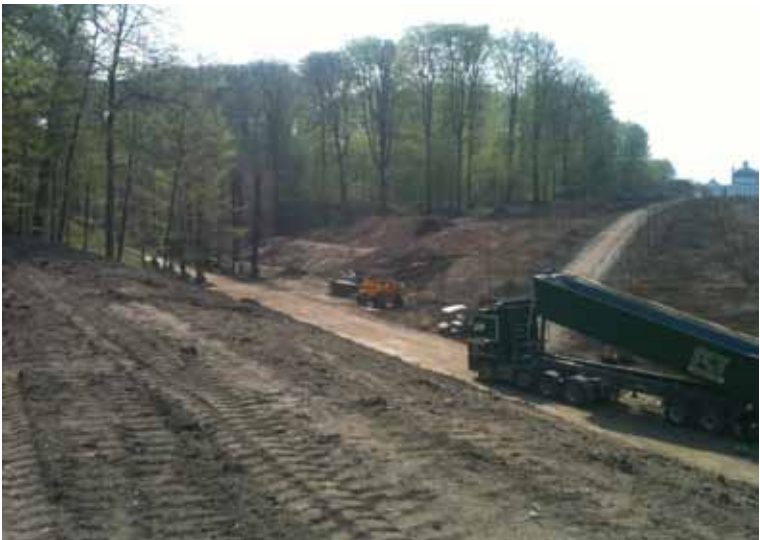
Jordarbejde skaber niveauforskel. Foto Schönherr.
