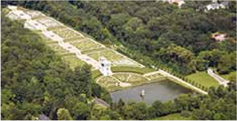
Gottorf Slotshave, som anlægget tager sig ud nu. Rekonstruktion gennemført i 1990'erne. Luffoto.
