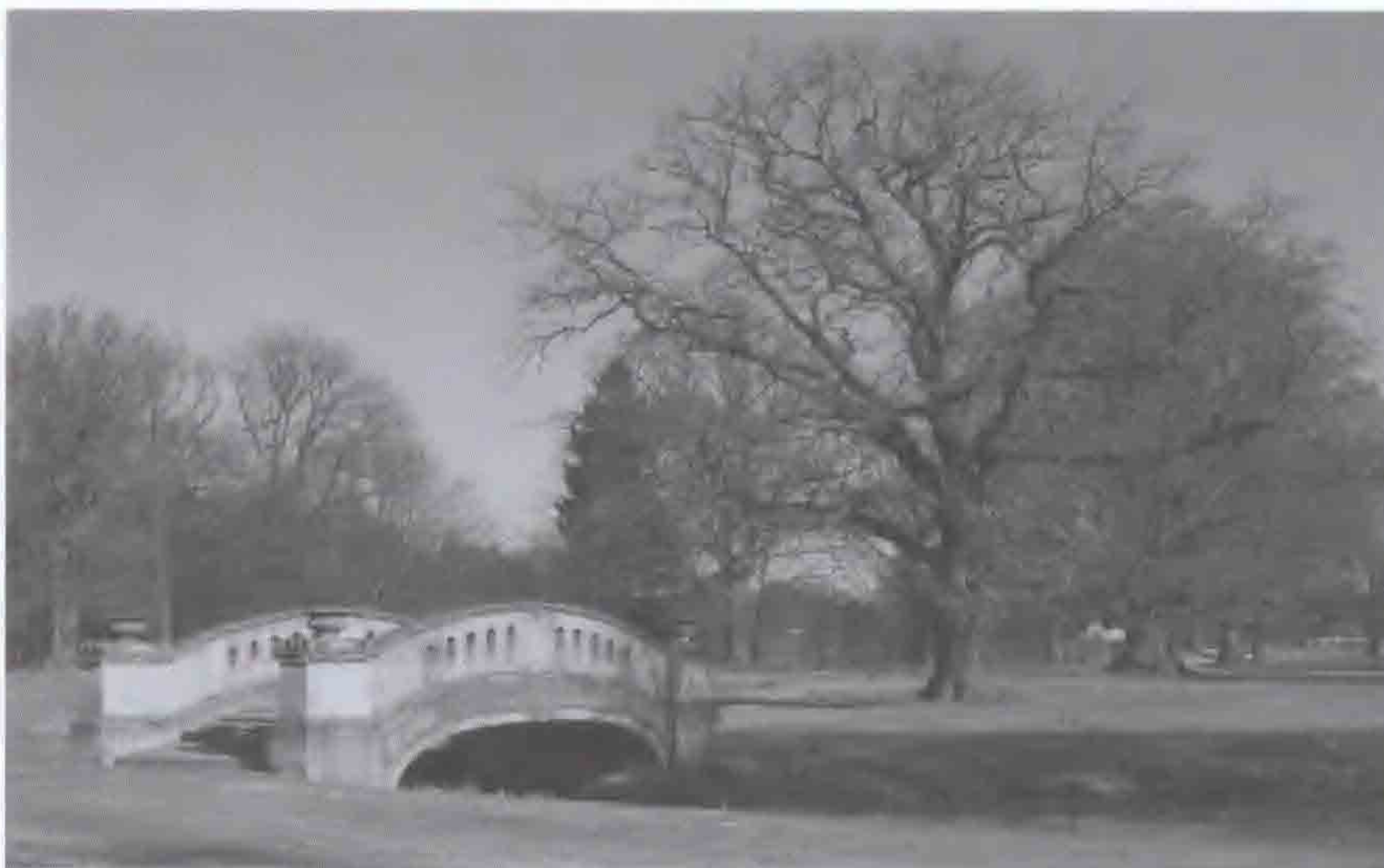
Fig. 17. Betonbro fra Carl Olsens tid 1917-1927 Oversigtskort nr. 20. Foto F.T. Sørensen, 2011.
