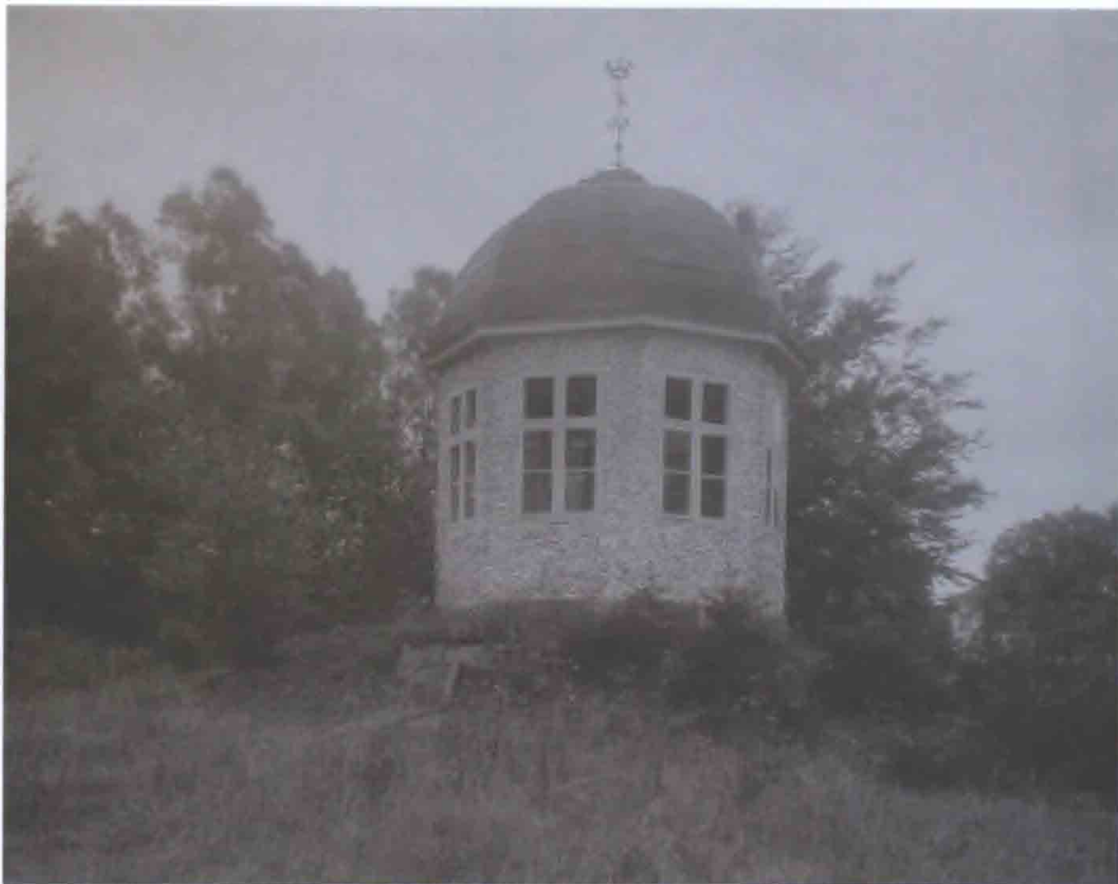
Fig. 7. Tepavillonen, beklædt med østersskaller, på toppen af Bøgholm og oven på iskældereren. Ved siden af tepavillonen ses lemmen, hvor isen blev firet ned i iskældereren. Det Kongelige Bibliotek, Kort- og Billededeafdeling.
