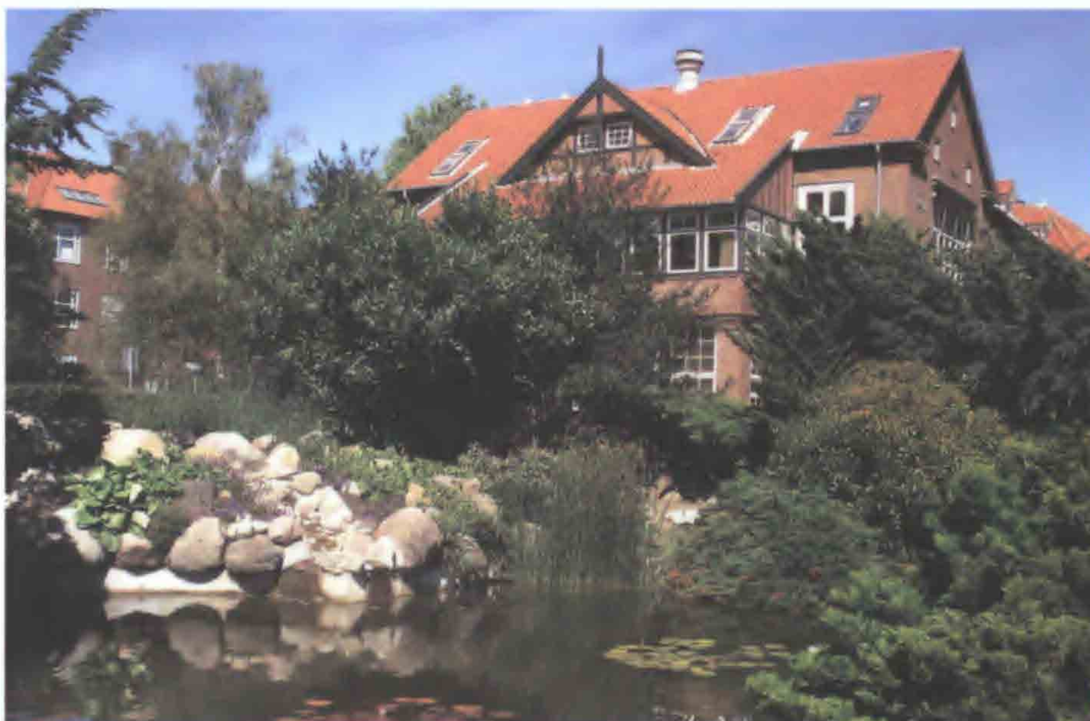
Fig. 7. Fotografi af søen 2008. Bagved til højre ses sygepavillon 6; til venstre den senere opførte korridorbygning 7. Det fremgår tydeligt, at beplantningen danner et spændende og underholdende led i hospitalets arkitektur. (foto: H.P. 2008)
