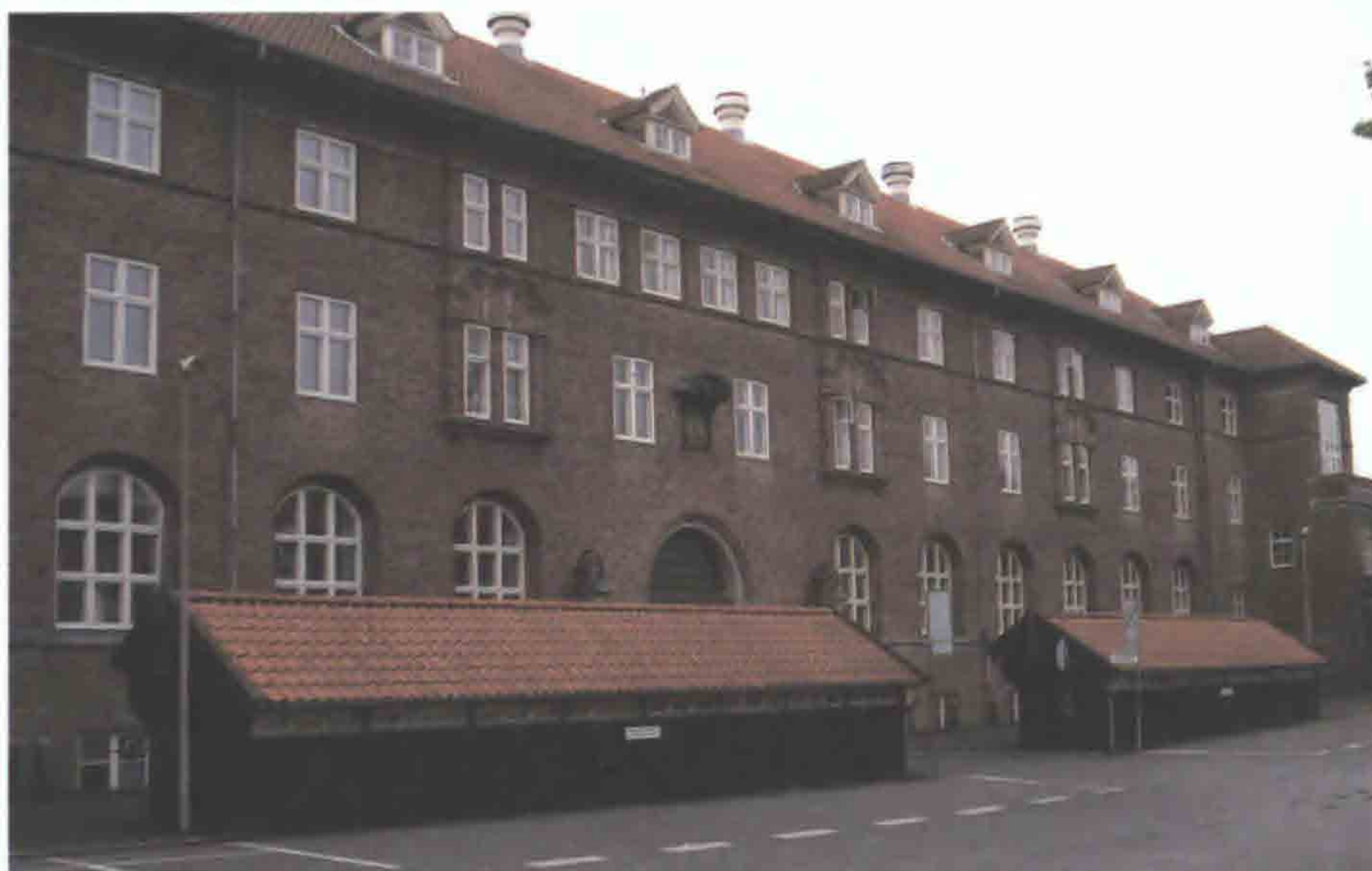
Fig. 3. Nyrops cykelskure placeret ved administrationsbygningens bagside. Det er næppe muligt, at udforme sådanne skure mere diskret. (foto: H.P. 2008)
