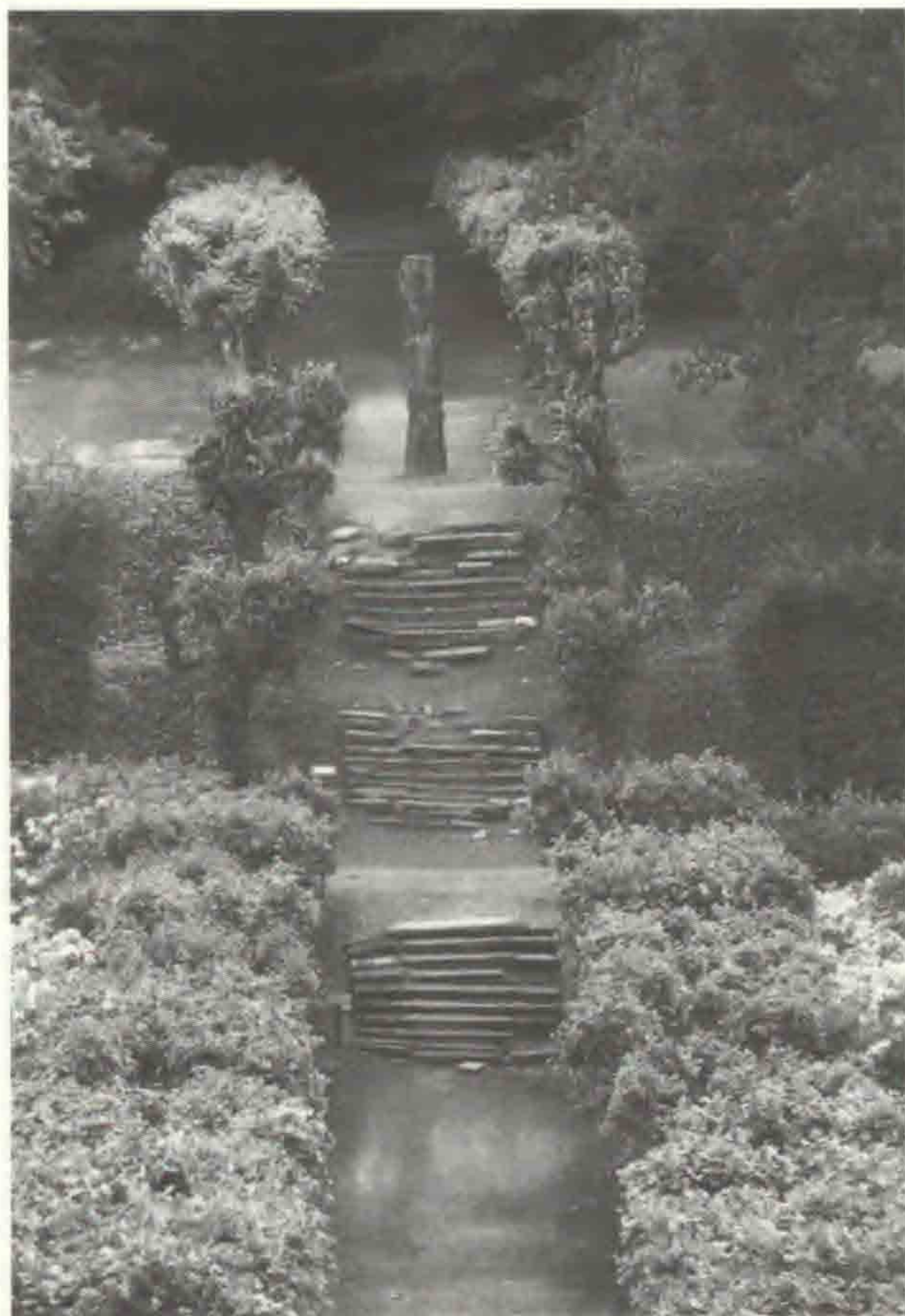
Fig.4. Grusstier og grannittrapper er skredet sammen og bliver således endnu svære at holde. Terrasseanlæg på Engelholm. (Foto Jørgen Jørgensen)
