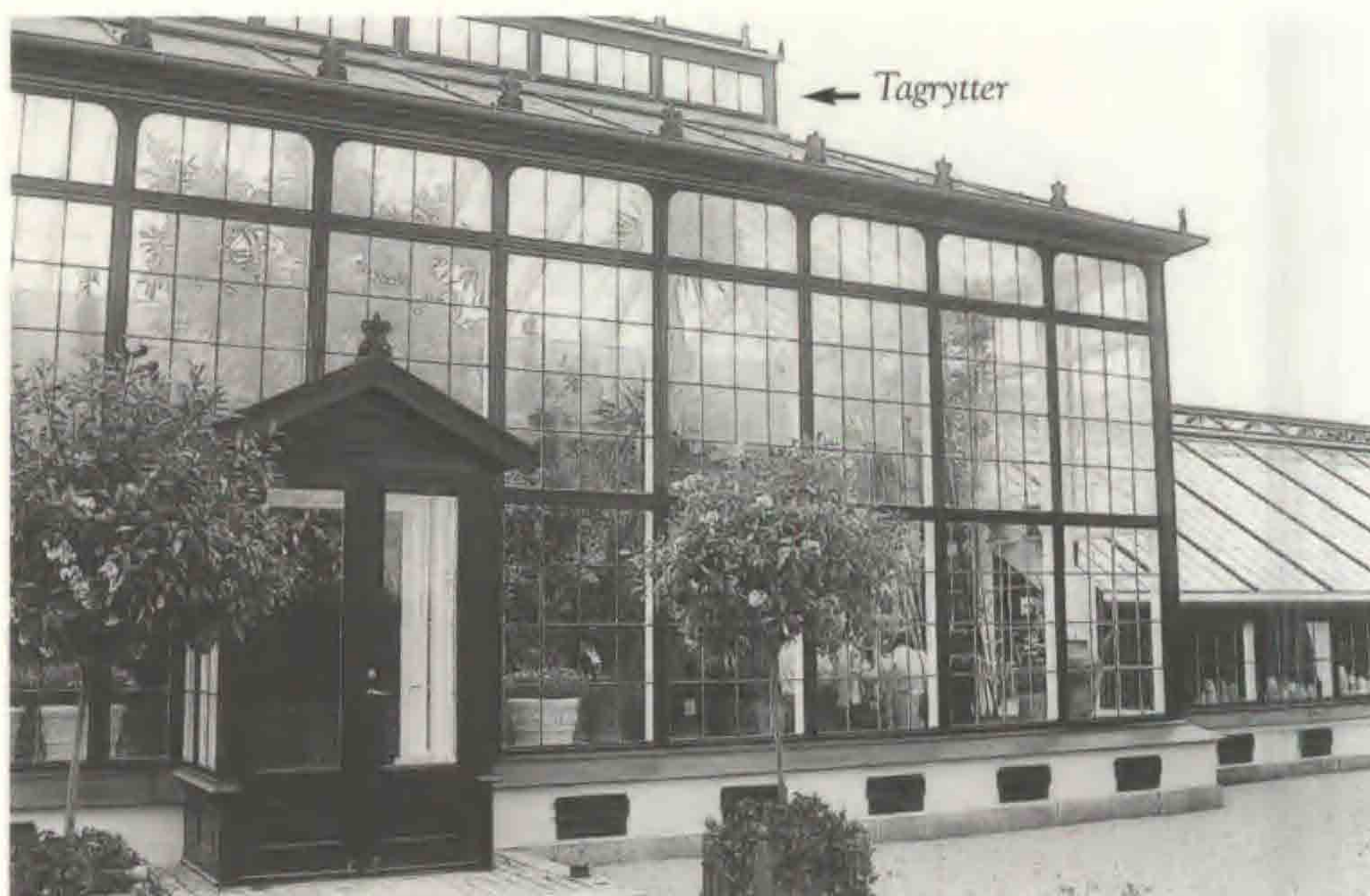
Fig. 5. Paradehusets midterste fløj med tagrytteren over taget og fremspringende vindfang. Forneden muret sokkel med udluftningslemme, (foto: Søren Cock-Clausen).
