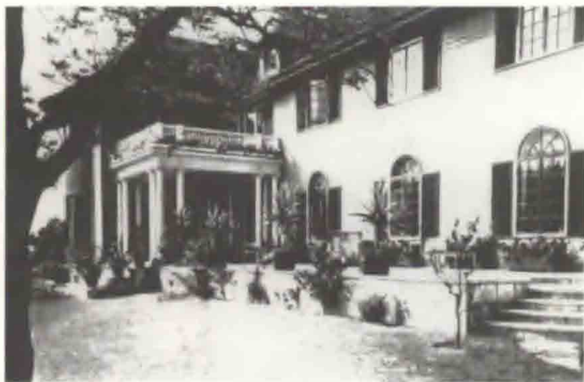
Fig. 1: Hovedbygningen ved Villa Svastika, Rungsted.
