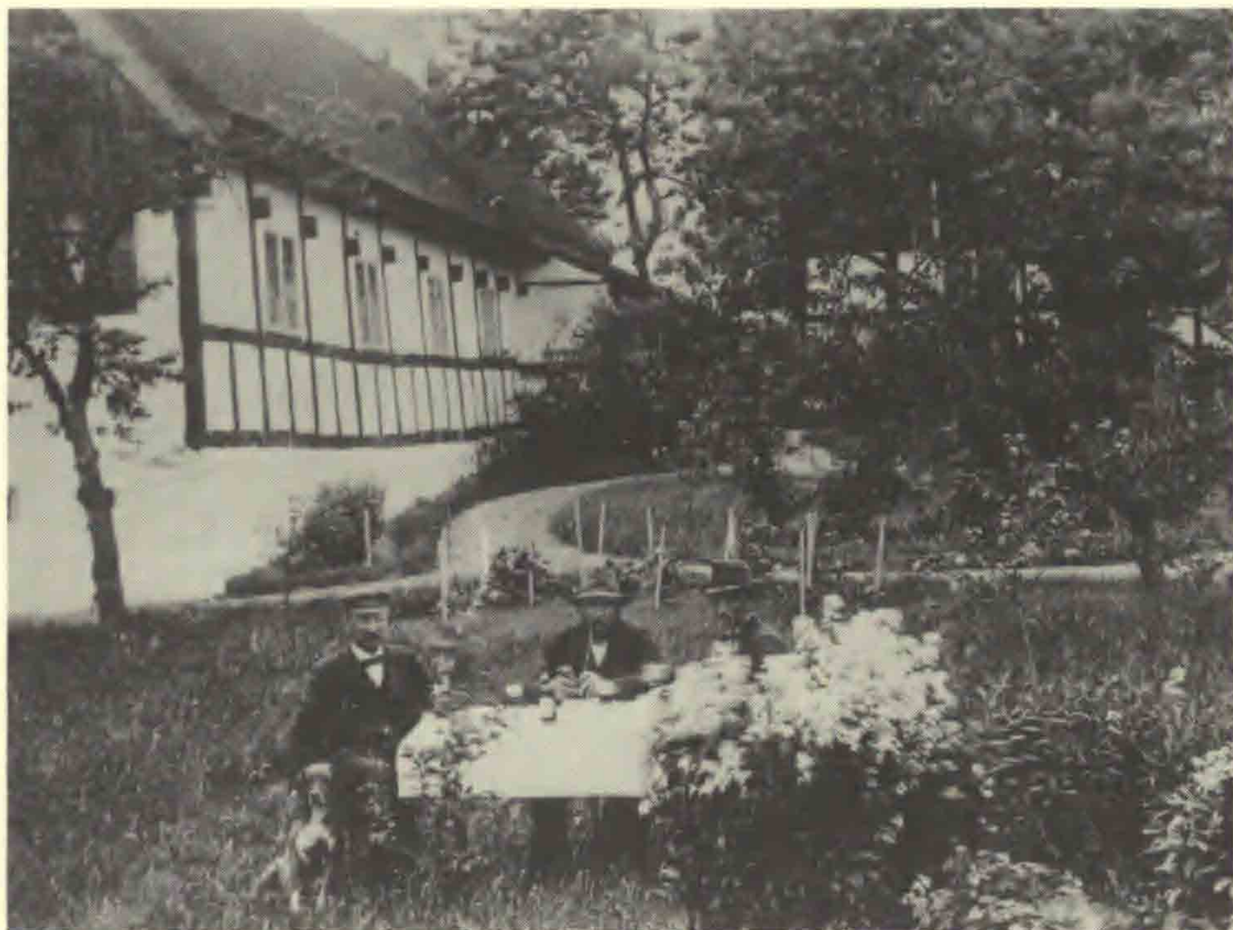
Damaskegården i Østerlars sogn nær Melsted ca 1915; bemærk det lille kvadratiske vindue i sokkelen yderst til venstre i billedet; det samme vindue ses på flg tegning af Damaskegården lige til højre for kælder døren i sokkelen. Angående havestilen mærk især at gangene er krumme, og at der næsten ingen stauder står op ad huset. Foto fra Bornholms Museum.
