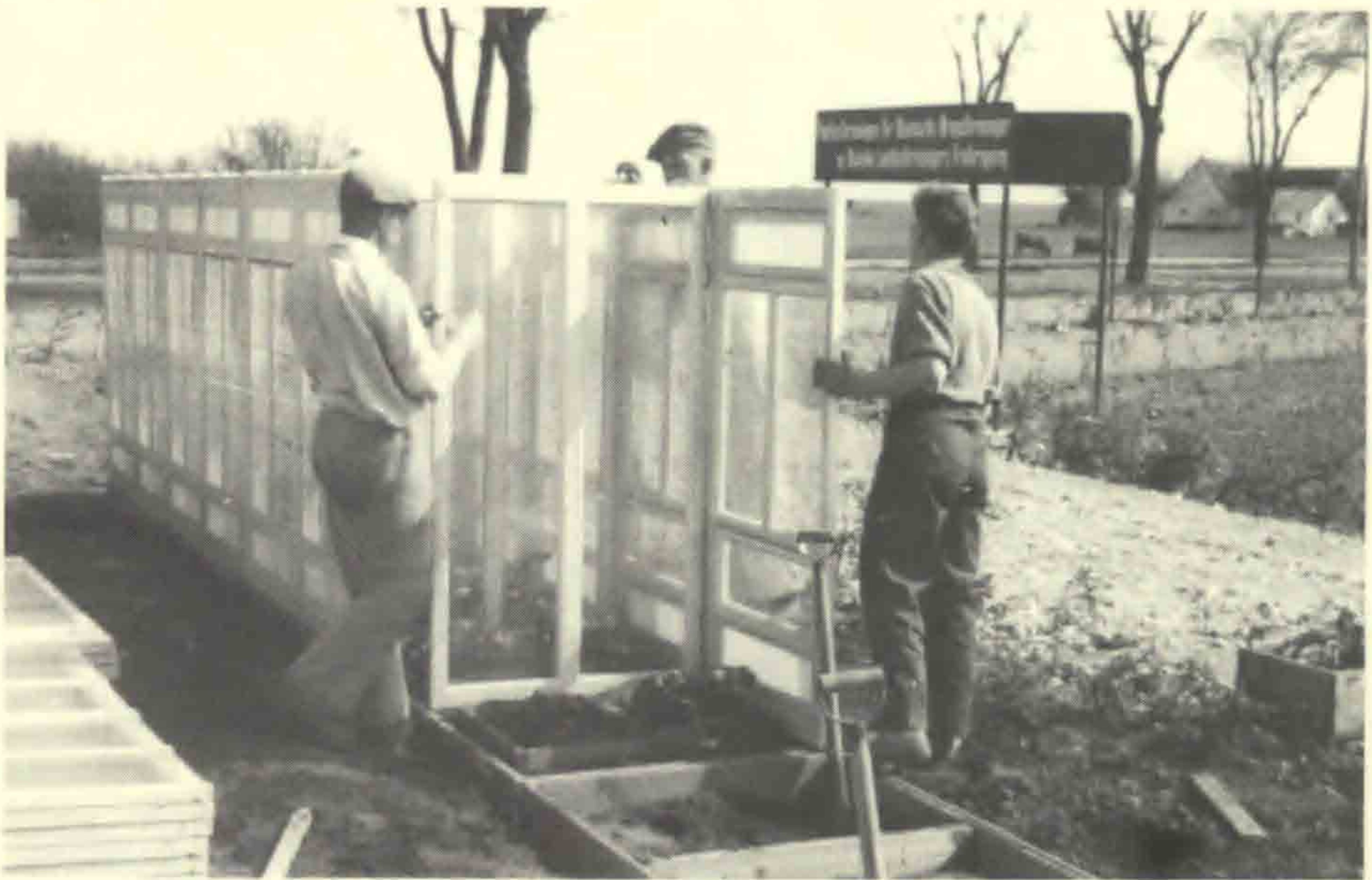
Parkrydsningshuse opstilles til samisolering af rødbeder. Toftø
