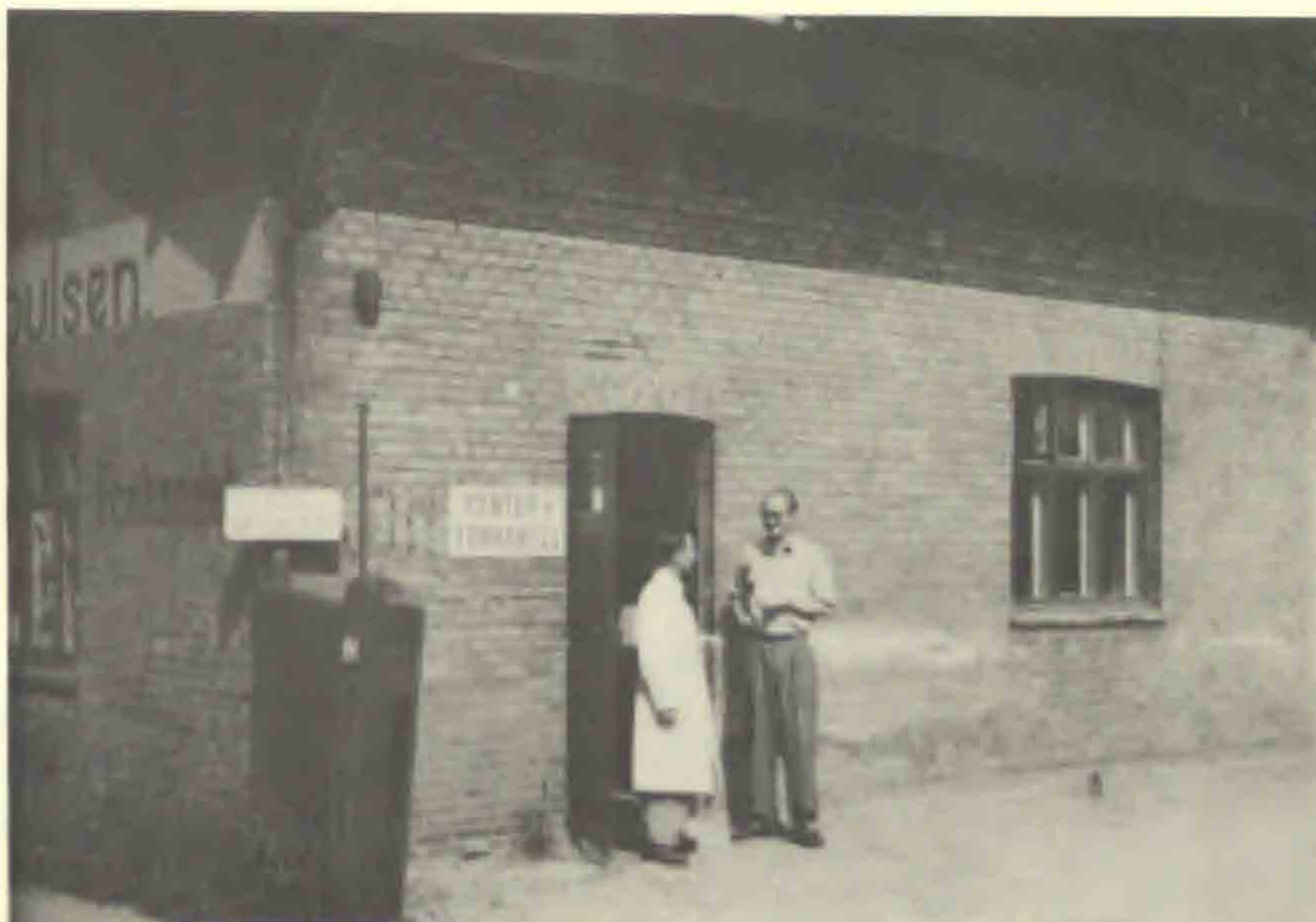
4. Samme bygning som ovenfor. Dines Poulsen jun. til højre.
