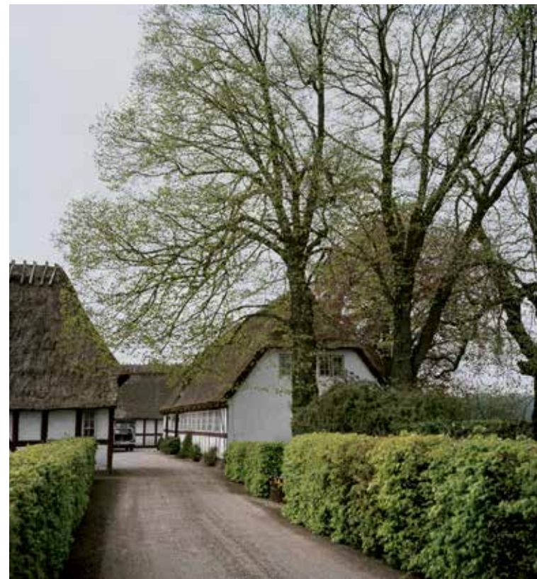
Indkørsel med karakteristiske lave hække og to træer ved gavlen. Gård ved Svendborg. Foto Agnete Muusfeldt, 1978
