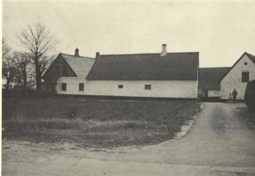
"Morbroders Minde". Typisk firlænget amager-gård. Hovedgaden nr. 3, St. Magleby. Stråtag på udlænger erstattet med eternit i 1954. Stuehuset bygget 1894 af min farfar Jan Adriansen, som i 1891 overtog gården efter morbroderen Tøns Jacobsen.
