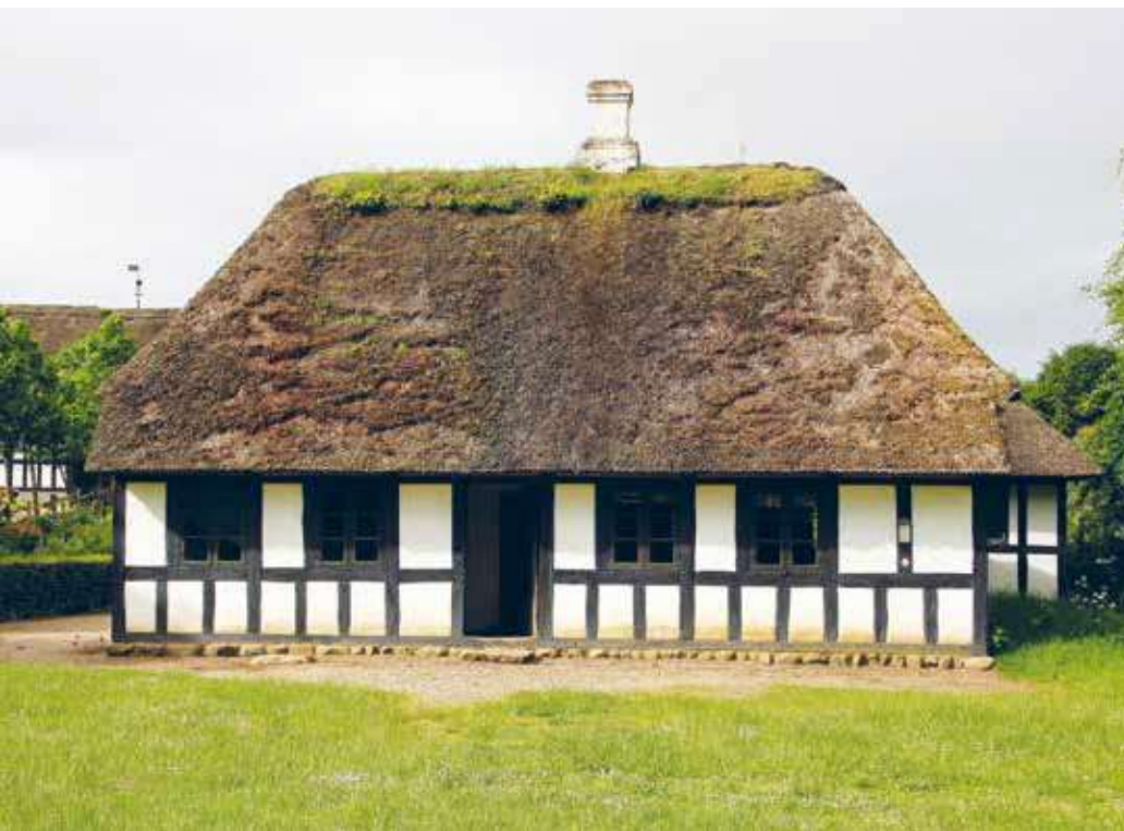
Hinge Skole set fra forsiden. Den afløste en tidligere skole fra 1700-tallet og var bygget efter de nyeste forskrifter for landsbyskoler. Da Martine flyttede ind på skolen i 1825 var den lige taget i brug
