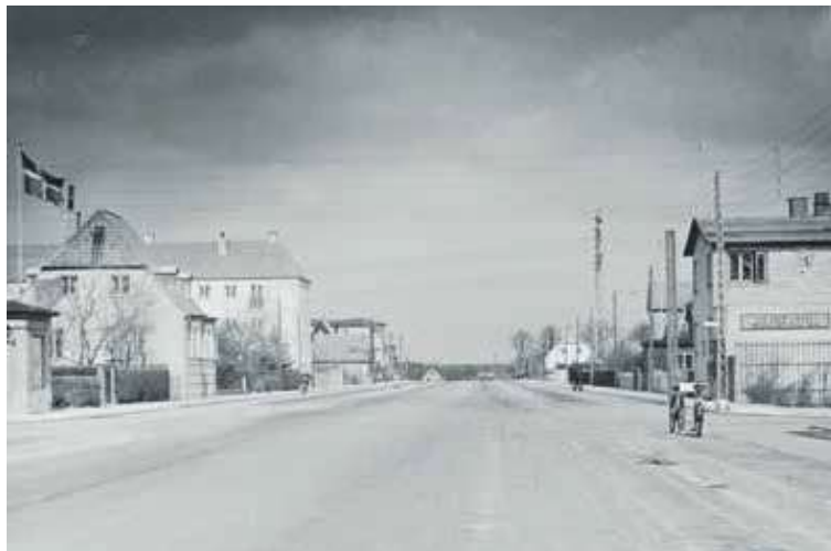
Buddingevej 1948. Vejudvidelse og separate cykelstier og fortove har efterladt Buddingevej træløs med et vejprofil der strækker sig fra facade til facade.
