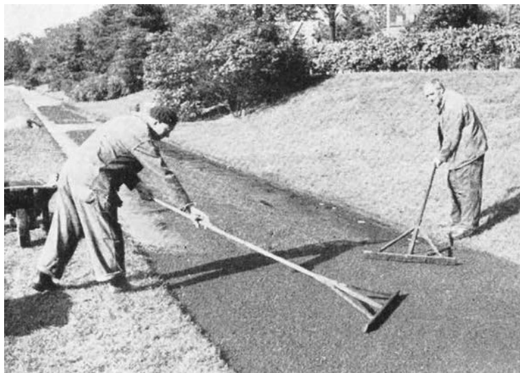
I 50'erne blev asfalt også almindeligt i anlægsgartneriet. Her udlægges der pulverasfalt på en gangsti en park. Fra Georg Boyes 'Anlægsgartneri' fra 1959. Foto: Willy Falck Hansen.
