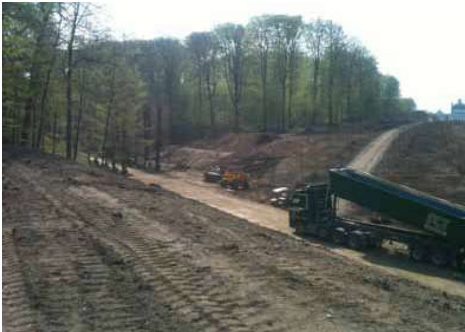
Jordarbejde skaber niveauforskel. Foto Schönherr.
