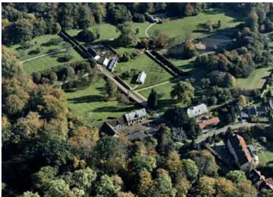
Bernstorff Slotshave. Luftfoto af Gartneriet Bernstorff, Avlsgården i forgrunden, Rosenhaven med Dronning Louises tehus tættest skoven og Svanedammen til højre i billedet. Foto: Finn Christoffersen. Slotte og Kulturejendommens arkiv.
