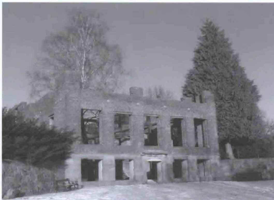
Fig. 19. Aldershvile set fra syd, med Grevindens gravsten nederst i venstre hjørne. 2010. Kampestensmuren i venstre side er flere hundrede meter lang. Muren i højre side er i dag kun få meter lang.
