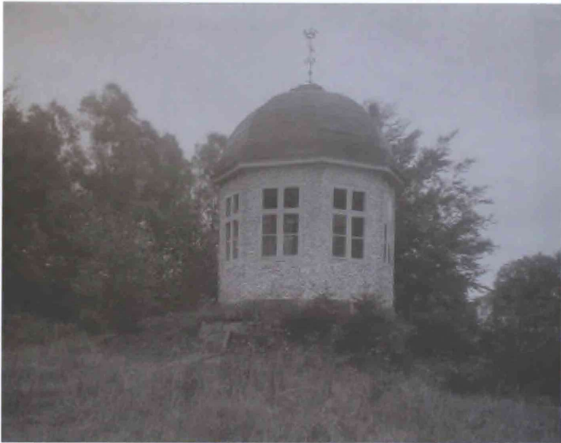
Fig. 7. Tepavillonen, beklædt med østersskaller, på toppen af Bøgholm og oven på iskældereren. Ved siden af tepavillonen ses lemmen, hvor isen blev firet ned i iskældereren. Det Kongelige Bibliotek, Kort- og Billedeafdeling.
