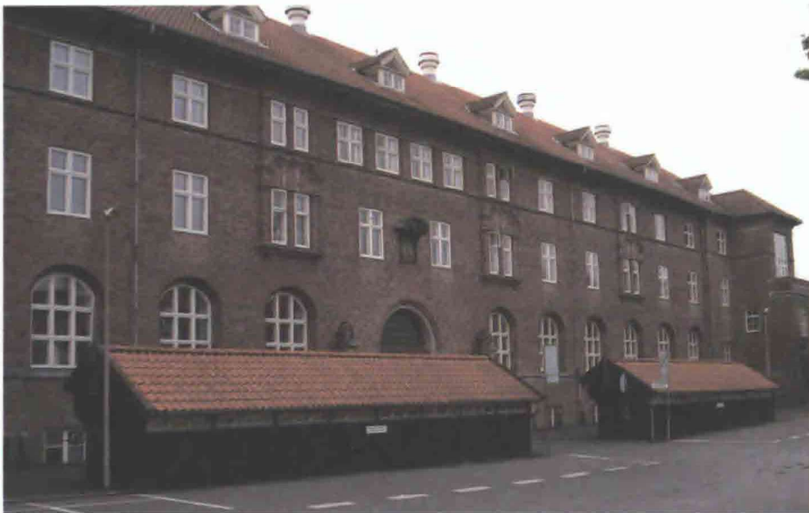
Fig. 3. Nyrops cykelskure placeret ved administrationsbygningens bagside. Det er næppe muligt, at udforme sådanne skure mere diskret. (foto: H.P. 2008)
