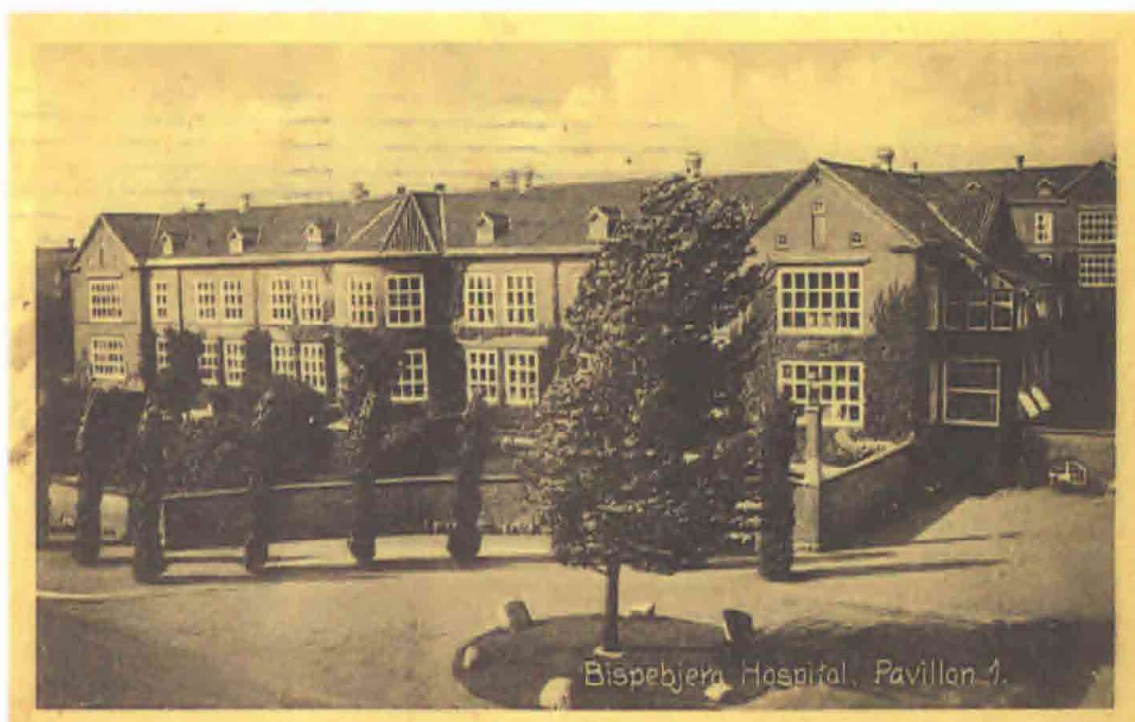
Fig. 4. Postkort med fotografi af haven ved sygepavillon 1 set fra administrationsbygningen ca. 1920. Pladsen domineres af en stor poppel, langs muren søjleformede ege. Bag dem ses hækken rundt om den centrale plads. (Bispebjerg Hospitals arkiv)
