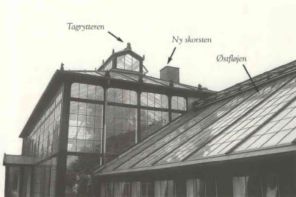
Fig. 6. Bagest midterfløjens gavl mod øst og tagrytteren med den åbne rude mod nord. Til højre østfløjens glastag med åbne udluftningslemme foroven, (foto: Søren Cock-Clausen).
