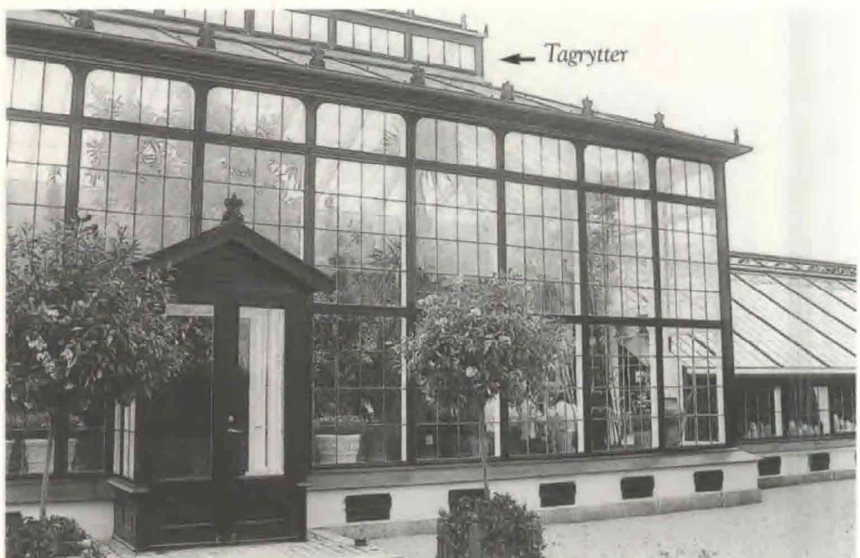
Fig. 5. Paradehusets midterste fløj med tagrytteren over taget og fremspringende vindfang. Forneden muret sokkel med udluftningslemme, (foto: Søren Cock-Clausen).
