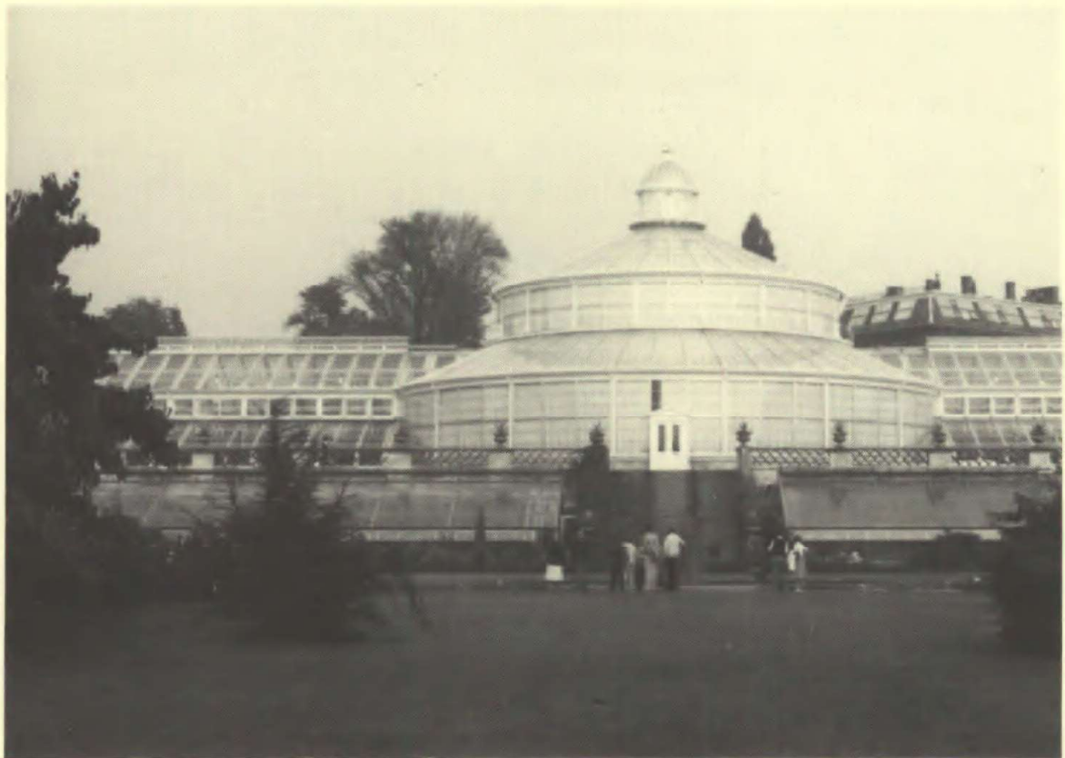
Væksthusenes centrale del ved genindvielsen 1982
