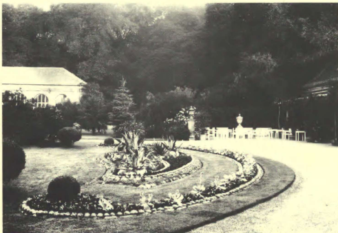
Som haven præsenterede sig i mange år før 2. verdenskrig nærmest indgangen fra Frederiksberg Runddel. Brøndsalen t.v., udstillingssalen og gartnerboligen t.h. Juli 1935.
