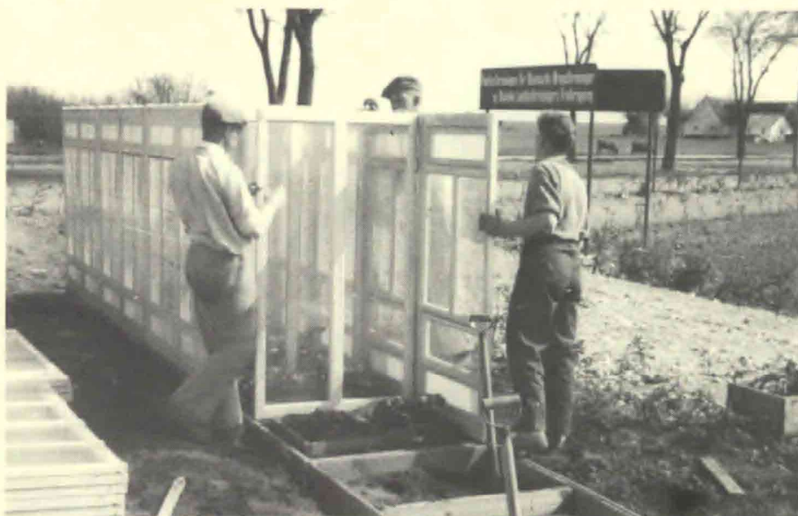
Parkrydningshuse opstilles til samisolering af rødbeder, Toftø
