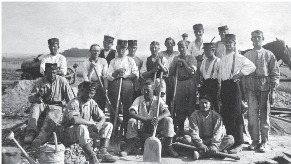
Arbejdshold fra ingeniørtropperne som dette havde i hele sikringsperioden været i gang med at etablere nye feltbefæstninger for at forbedre Hærens indsatsmuligheder, men fra vinteren 1916/17 standsede Munch alle nyanlæg og forbedringer. Herefter kunne man kun indkøbe og oplægge materialer til arbejde efter en mobiliseringsbeslutning, som den radikale regering aldrig ville tage. (Foto: Rigsarkivet)
