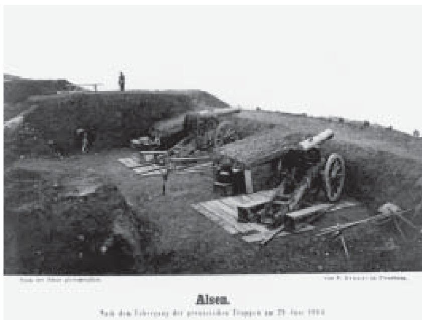
Efter kampen. Glatløbet batteri opstillet til frontal skydning. Billedet viser to 4-punds opriflede bronzekanoner ved Slotsbatteriet (altså ikke i nærheden af overgangstederne). (Fotografi. F.C. Brandt. Det Kongelige Bibliotek)
