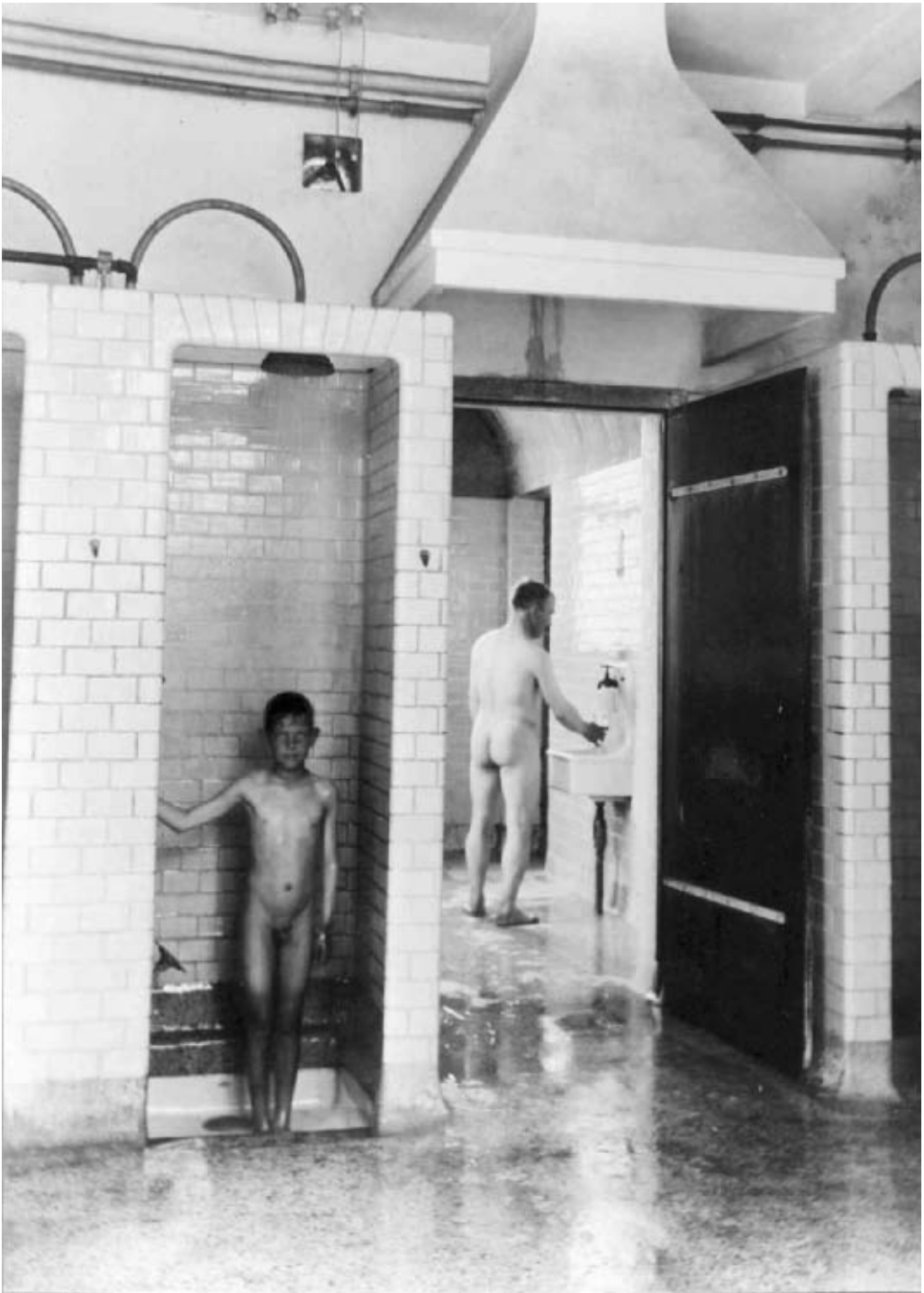
Baderum i Idrætshuset, Københavns Idrætspark ca. 1920. Fotografi udlånt af Københavns Idrætsanlæg.
