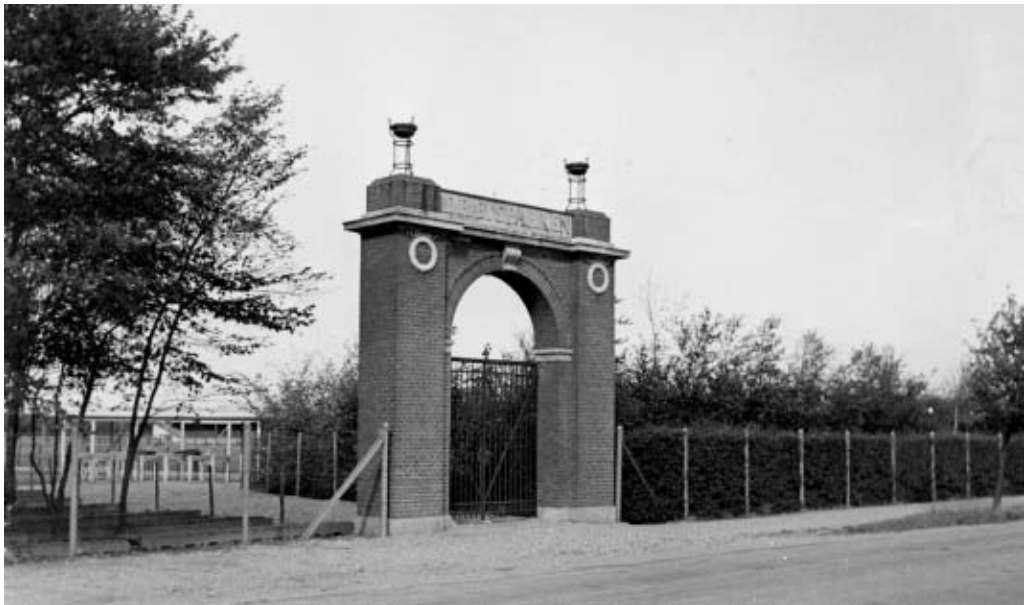
Esbjerg Idrætspark fra 1929 fik en markant hovedindgang, tegnet af C.H. Clausen, en af Esbjergs kendte arkitekter. På portalens top var der anbragt to »olympiske« skåle – ikke til ild, men udelukkende som symbolsk pynt. Foto fra 1930-35. Esbjerg Byhistoriske Arkiv, neg. 3813
