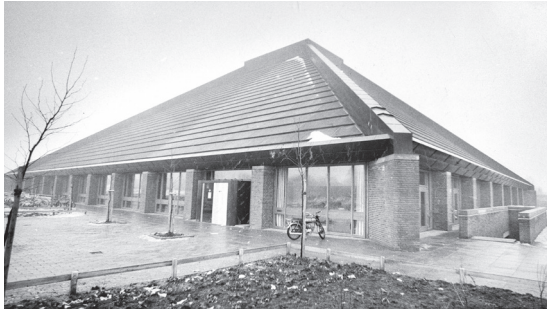
Greve Svømmehal med sin pyramideform blev i 1978 praktisk placeret ved siden af Greve midtby center og Greve station. Kommunen havde også tænkt på energiforbruget, hvorfor taget var forsynet med solceller, der skulle producere strøm til svømmehallen. (Foto fra Greve Museum)
