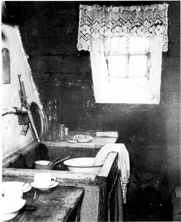
Odense købstads boligkommission konstaterede i 1947, at det bl.a. regnede ned gennem taget, og at vasken manglede vandlås i denne ejendom i Fredensgade. Kommissionen krævede de værste mangler udbedret, og det blev tinglyst på ejendommen, at køkkenet og enkelte andre rum skulle fjernes inden 10 år. Fornyede klager i 1959 viser, at ikke alt blev bedre, og i 1989 – efter Huslejerforeningens mellemkomst – vedtog boligkommissionen forbud mod ejendommens anvendelse til beboelse eller opholdssted for mennesker. I 1990 blev huset revet ned. (Foto: Boligkommissionen, Odense kommune).
