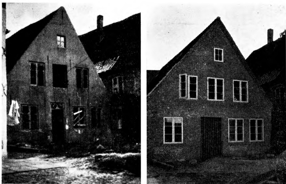
Østergade 58 – før og efter restaurering
