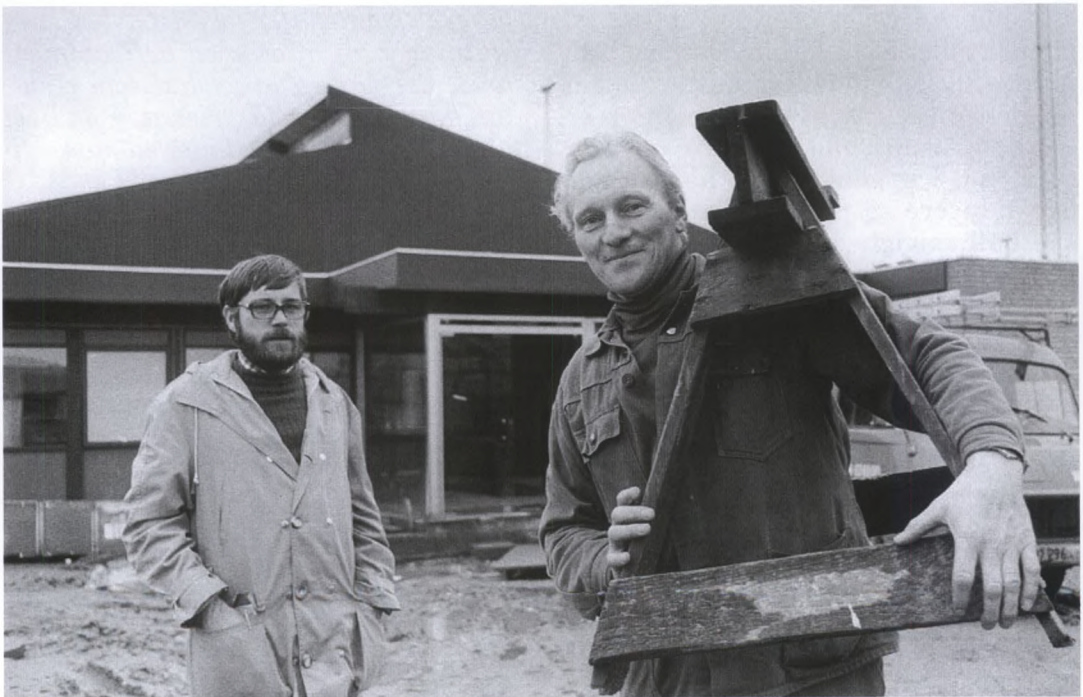
Agerskov-hallen, indviet 2. oktober 1975, ved opførelsen i december 1974. I forgrunden ses pedel ved Agerskov Skole, Laurids Mikkelsen, som af alle blev udnævnt som den største slider under hele byggeperioden. I baggrunden ses konstruktør Johnie Kühnau. Foto: Vestkysten, 2. december 1974.
