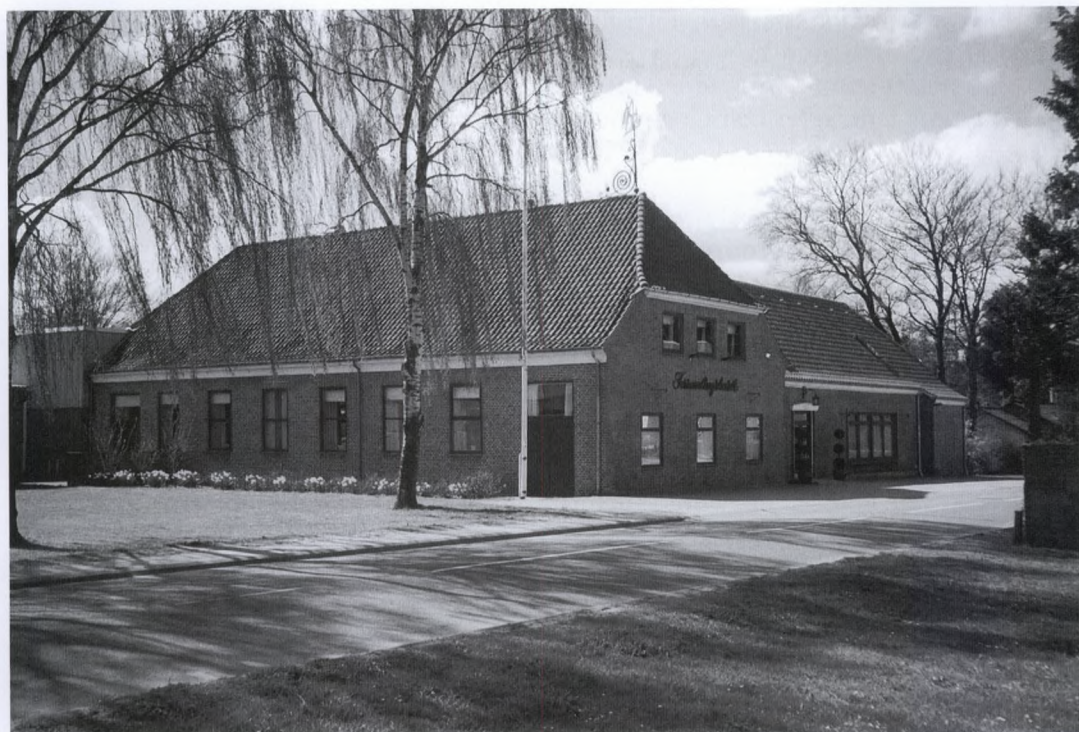
Forsamlingshuset i Ryslinge på Fyn. Opført 1871. (Foto: forfatteren, februar 2001).
