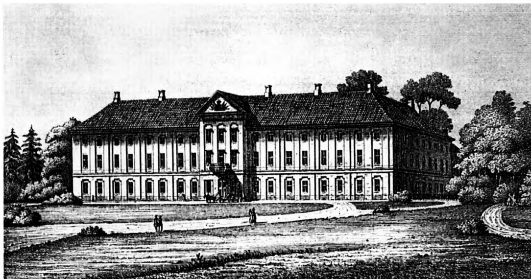
Fig. 6. Augustenborg slot er bygget i årene 1770-76, og er et strengt symmetrisk og forholdsvis sparsomt udsmykket anlæg. Midterpartiet domineres af en gennemgående risalit, der hæver sig i alle hovedfløjens tre etagers højde, og som afsluttes af store, hævede frontoner med det hertugelige våben i sandstensrelief (Stik fra ca. 1840. Nationalmuseet).
