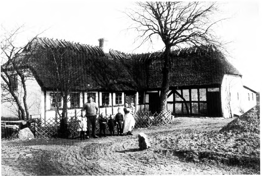
Matr.nr. 52d på Houbanken i Rønninge fotograferet omkring 1915. Huset havde da samme størrelse som da det i 1849 blev brandforsikret for første gang, men det var siden blevet forsynet med brændte sten i stedet for lerklinede vægge. Huset var indtil 1867 fæstehus under Rønninge Søgaard, hvorefter det overgik til selveje. Enken efter den tidligere fæster blev boende i huset, og køberen forpligtede sig til at give hende aftægt, mod til gengæld at betale lavere renter af Rønninge Søgaards prioritet så længe enken levede. Foto: Langeskov Kommunes Lokalhistoriske Arkiv.
