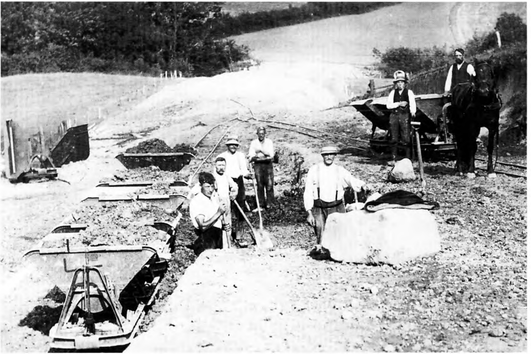
Anlæggelsen af »Minutvejen« i Ensted sogn ca. 1935. Vejen indgik som en del af den store vejplan for udbygningen af landevejene i Sønderjylland, som Ministeriet for offentlige Arbejder og de sønderjyske amter aftalte i 1921. Det kryptiske navn fik vejen af lokalbefolkningen, som mente, at der nok blev anvendt lidt rigeligt med penge på en vej, der kun gav en minimal besparelse i rejsetiden. Ikke desto mindre var det veje som denne, der efter Genforeningen bidrog til at gøre mange af de snoede kommuneveje overflødige. Foto: Institut for Sønderjysk Lokalhistorie.
