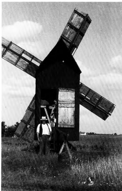
Fig. 8. Lille stubmølle bygget som husmølle til gården Storhaven på Læsø, nu på Frilandsmuseet i Sorgenfri. – Det er stubmøller som denne, der i 1700-tallets skriftlige kilder benævnes »skvatmøller« (Stoklund 1969). Foto: Ove Jepsen 1946.
