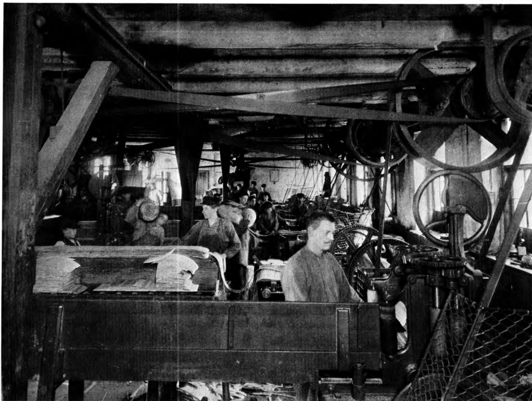
Fig. 1. Et af skærerierne på De Forenede Tændstikfabrikker år 1905. Som transmissionssystem betød de roterende aksler og remtræk i datidens fabrikker en konstant fare for arbejdsulykker. Foto i ABA.
