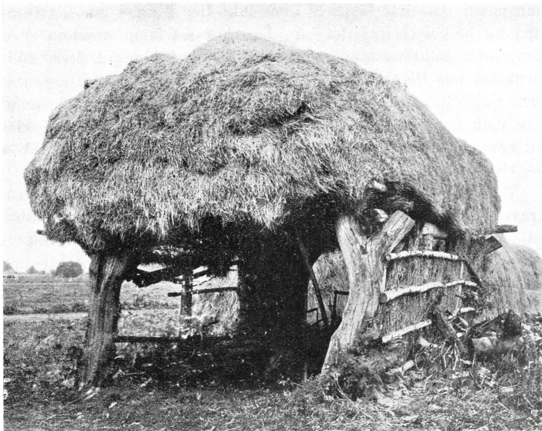
Fig. 1. Havrebod fra Teglstруп, Baarse h., Præstø amt. (K. Uldall fot.). Taget bæres af fire jordgravede stolper, der foroven ender i naturgroede tvejer. I tvejerne ligger to tagremme. Mellem disse er der lagt bjælker, hvorpaa halmen ligger.
