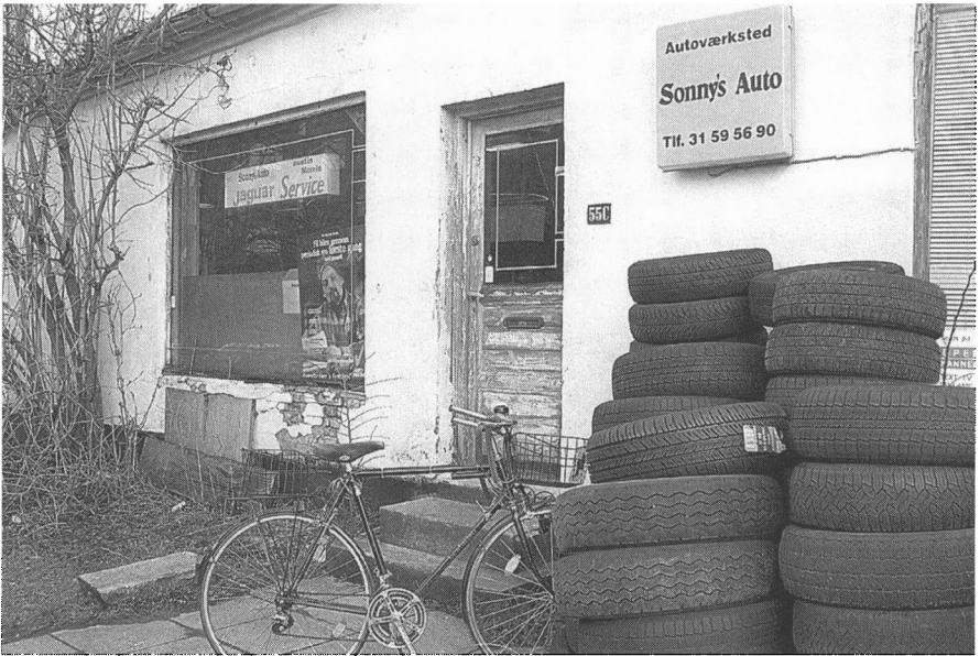
Sonny's autoværksted, Øresundsvej 55 C, 2300 København S. Nedrevet august 1999. Fot. René Christensen februar 1999.
