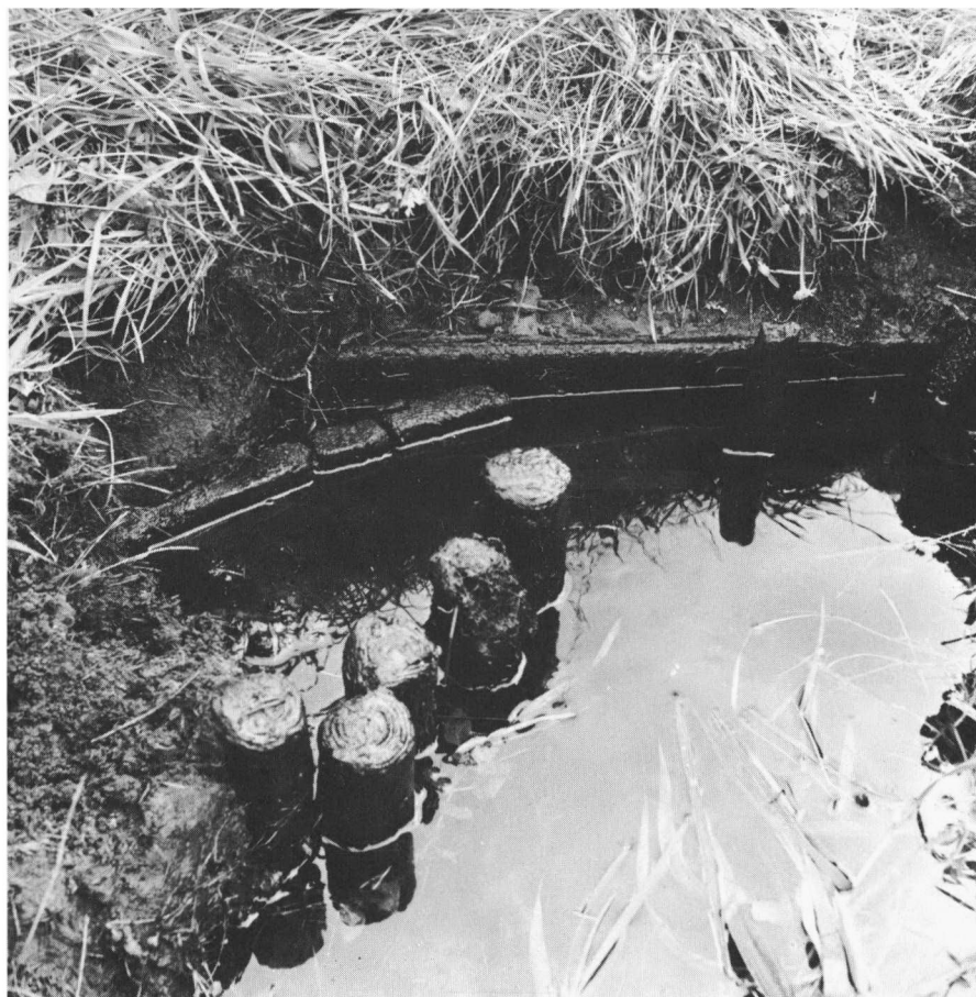
Engvandingsanlæg ved grindsted å. Ved rendeudløbene kan vandingen reguleres med træskodder. Fot. Bjarne Stoklund 1953.
