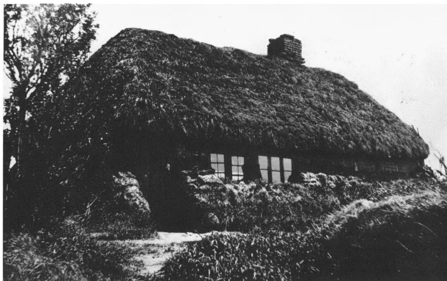
Gamle Trines hus i Haderup. Opstabilede lyngtørv beskytter husets ydermure, ligesom taget er tækket lagvis med halm og lyng. Fot. Poul Jensen 1923.
