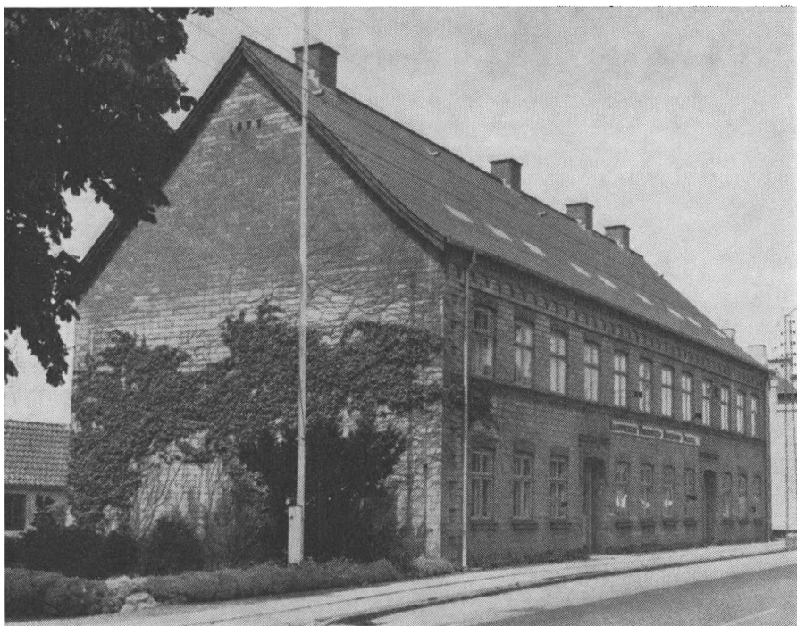
Fig. 16. Håndværker Foreningens Alderdoms Boliger, St. Heddinge. Bygningen er opført af kridtsten. Facadens murbånd, dør- og vinduesindfatninger er udført med røde teglsten. Fot. C. Hess 1969.
