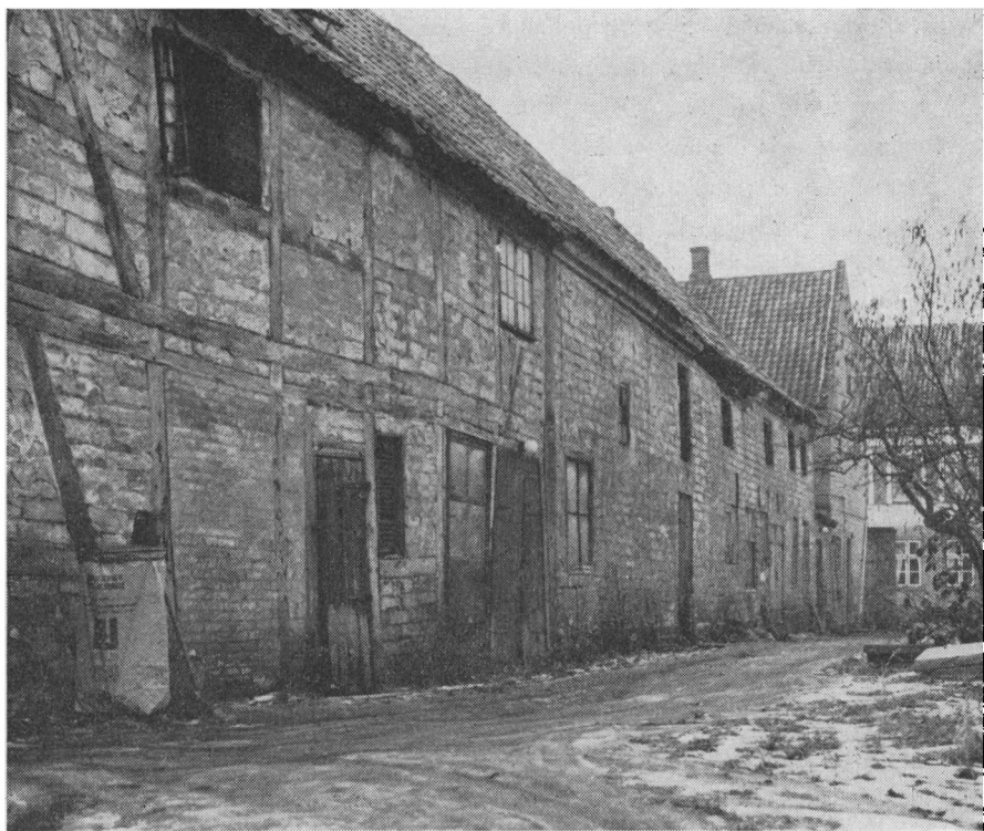
Fig. 11. Tidl. »Grams Brændevinsbrænderi« ved Algade i St. Heddinge. Den ældste del er bygget af bindingsværk med kridtsten. En nyere længe er opført som en grundmuret kridtstensbygning. Fot. C. Hess. 1969.
