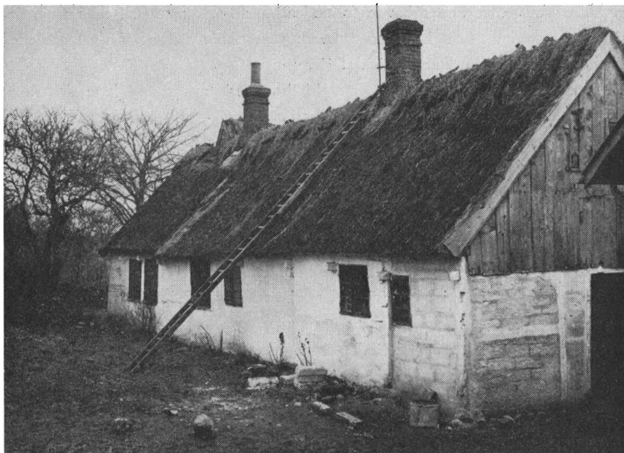
Fig. 10. Stuehuset på Mosegården i Sierslev by nær klinten. Efter byggemåden at dømme er huset fra slutningen af 1700-årene. Bindingsværksfelterne er nu for størstedelens vedkommende udmuret med kridtsten, men formodentlig er huset i sin tid opført med lerklinede felter som så mange andre gårde i byen. De øverste murfelter ud for kridtstenene på jorden er endnu ikke blevet udskiftet med murværk. De er endnu lerklinede. Kort før billedet blev taget, havde man netop udmuret de to felter ved hjørnet med nogle gamle kridtsten, man havde ved hånden. Fot. C. Hess. 1969.
