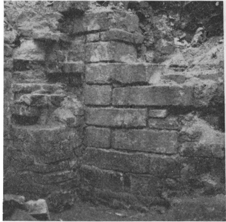
Fig. 6. Da man i 1970 nedrev en række ildebrandshuse i Landemærket, kom der flere steder kridtstensmure til syne. En kældervæg i det sidste hus før præstegården ved Trinitatis Kirke var således bygget af kridtsten. Fot. C. Hess. 1970.
