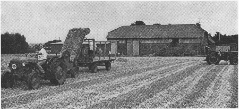
Stald og ladebygning til et af statshusmandsbrugene opført i 1950. Bygningen fik høj trempel med blikbeklædning, medens man lagde grå bølgeasbest på taget. Foto 1976 forf.
