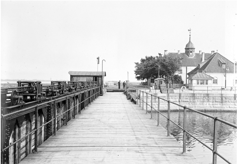
Ill. 6. Slusehuset og slusen, 1934. Københavns Museum. Stigborde med elektrisk hejseværk ses til venstre i billedet.
