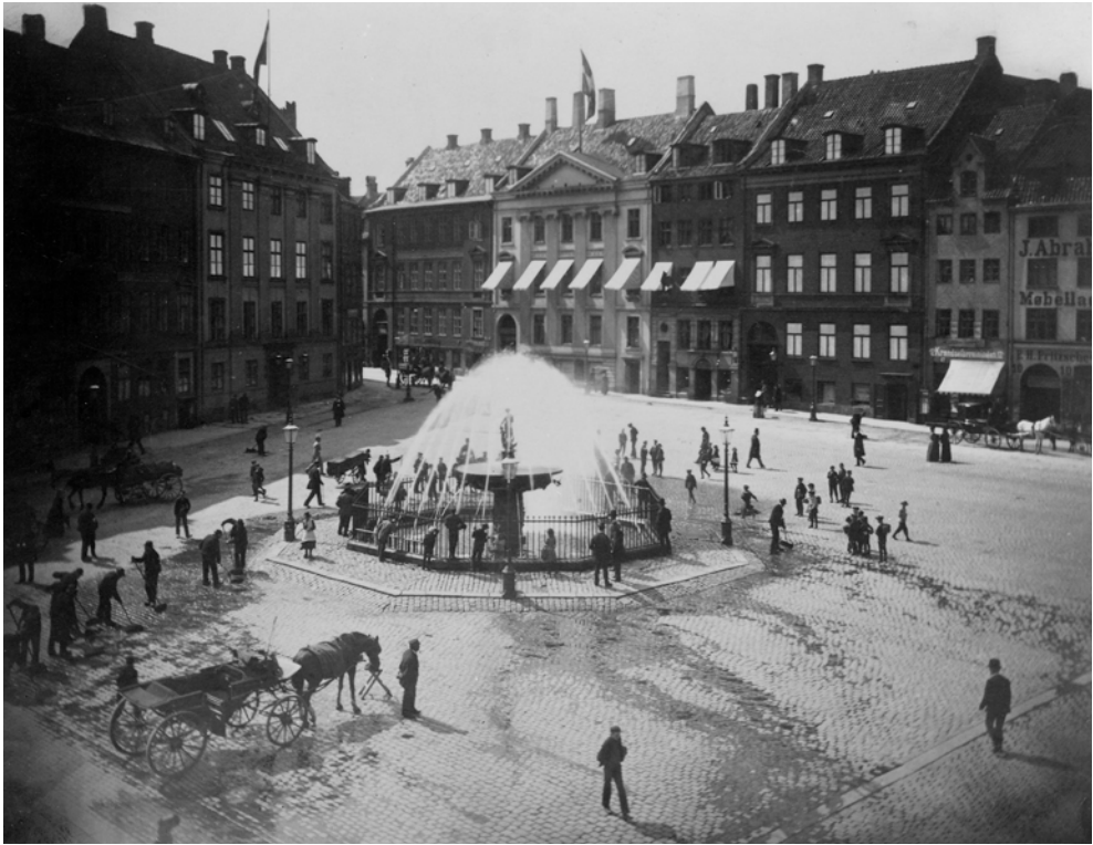
Ill. 3. Caritasbrønden, ca. 1890. Man ser på billedet, hvordan vandet på festdage sprang med forstærket kraft og fra supplerende dysser i gadeplan. Københavns Museum.
