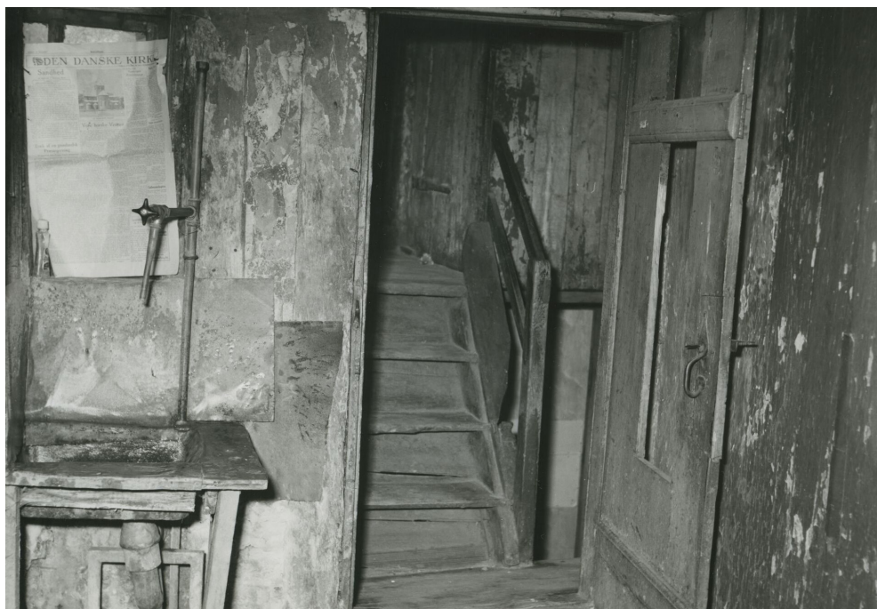
Nedslidt og utæt vask på gangen ved loftstrappen i ejendommen Klerkegade 36, 1957. Kilde: Københavns Stadsarkiv. Fotograf: Mogens Falk Jørgensen.
