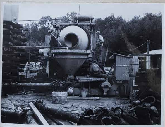
Blandemaskiner og betonpumpe. 10/8 1957.
