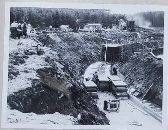
Støbning af dæk og vægge i 1. sektion. 10/8 1957.
