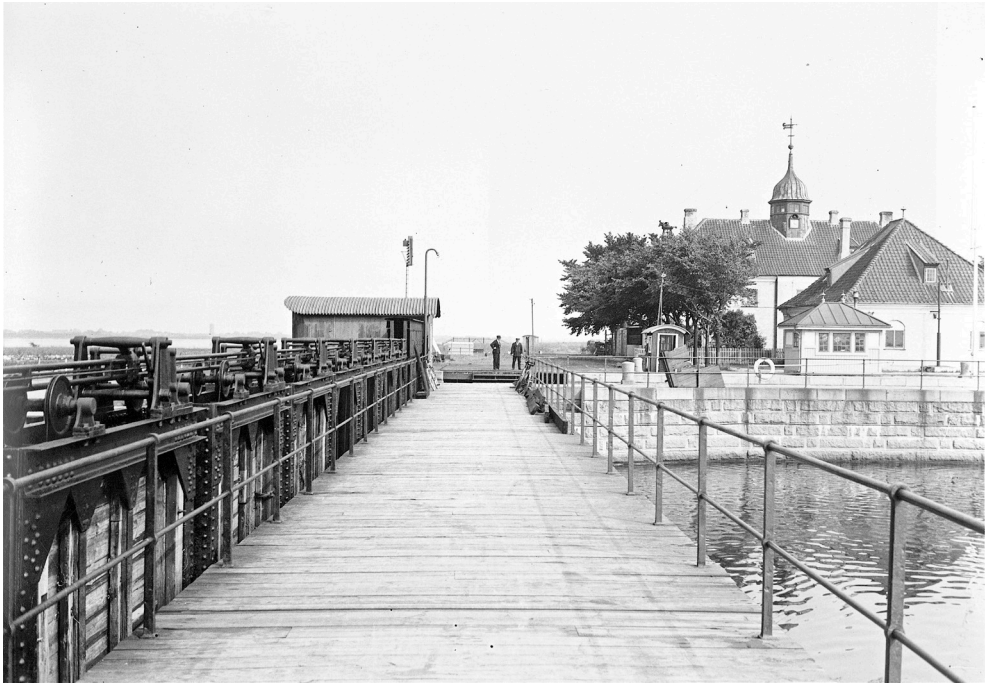
Ill. 6. Slusehuset og slusen, 1934. Københavns Museum. Stigborde med elektrisk hejseværk ses til venstre i billedet.
