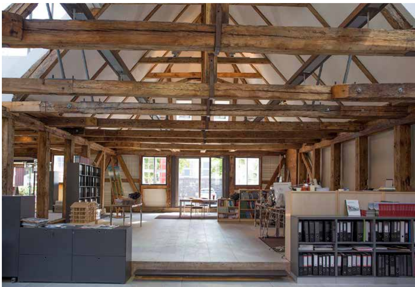
På grund af det særlige isoleringsprincip med termoglas på ydersiden af bindingsværkskonstruktionen oplever man stadig bindingsværkskonstruktionen i Masteskurene interør. Dette var et krav fra fredningsmyndighederne for at give tilladelse til omdannelse fra en kold uisoleret bygning til en opvarmet bygning. Fotograf: Sandra Gonon / Arkitekturbilleder.dk
