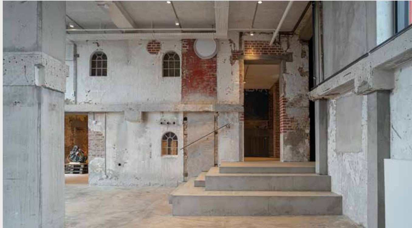
122 Nedgangen til børnebiblioteket i stueetagen i sydfløjen før indretningen. Resterne af det fjernede etagedæk er meget synlige, men illustrerer med al tydelighed hvad der kan opnås ved indgrebet. Foto: Jens Markus Lindhe.
