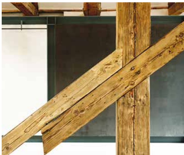
108 Søndre Masteskure. Ældre tømmerkonstruktion og bagvedliggende ny "funktionsboks" Foto: Arkitektfirmaet Frank Maali & Gemma Lalanda MLA/S
