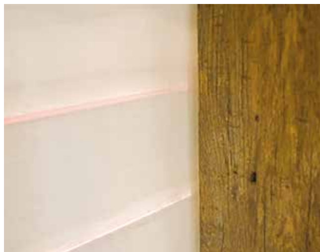
Søndre Masteskure. Det oprindelige bindingsværkskonstruktion med det lærreds-inddækkede glasparti med let lysindfald fra den mellemrummene i den vandrette klinkbeklædning Foto: Arkitektfirmaet Frank Maali & Gemma Lalanda MLA/S
