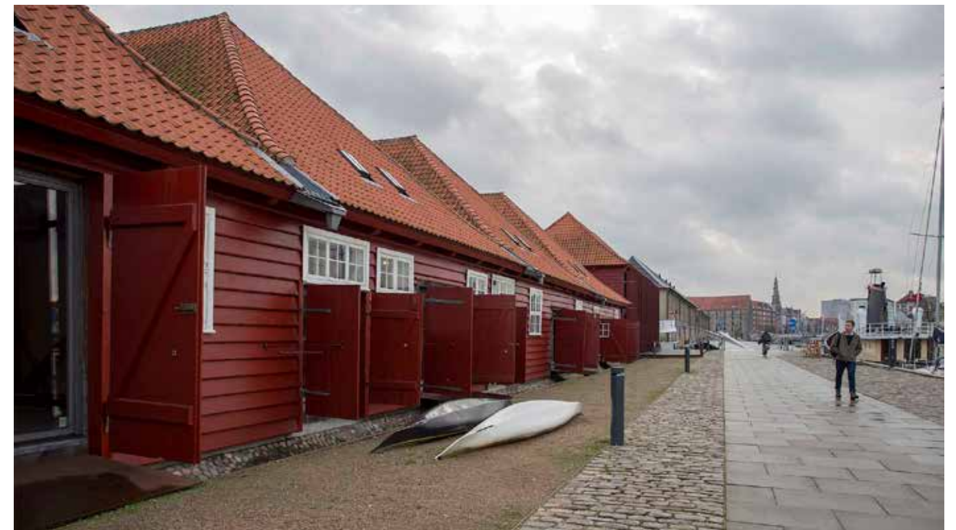
Søndre Masteskure - Vestfacaden mod havnen efter restaureringen med ældre porte og vinduer med håndmedede beslag. Bygningen er uden tagrender og nedløb og vandet fra tagfladerne ledes væk gennem pikstensbelagt rende. Som en konsekvens af den nyanlagte hævede vej ud mod havnen gav fredningsmyndighederne tilladelse til at hæve Masteskurene 84 cm i forhold til det oprindelige niveau, for at bygningerne fortsat skulle indgå i et logisk samspil med omgivelserne. Fotograf: Sandra Gonon / Arkitekturbilleder.dk
