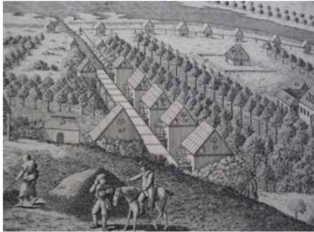
Detalje fra prospektet 1773. Krudtværket blev grundlagt i 1756 og fungerede helt frem til 1960'erne. Den gravede sidekanal sørgede for energi til de mange møller og stamper. Bemærk vandkassen, som forsynede møllehjulene med vand og de små klokker, der fra deres placering i gavlene "sladrede", hvis møller ikke kørte korrekt.
