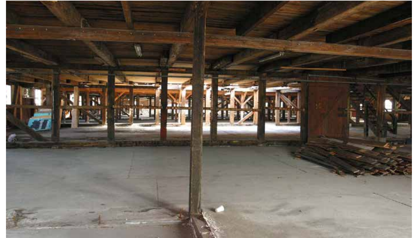
Søndre Masteskure - Den indvendige bindingsværkskonstruktion før restaureringen. Fotograf: Andreas Trier Mørch / Arkitekturbilleder.dk
