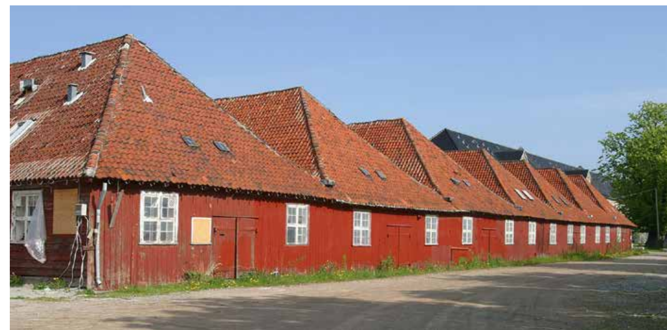
Søndre Masteskure med de syv sammenbyggede masteskure før restaureringen. Den lodrette brædebeklædning på østgavlene er kommet til sent i bygningens udviklingshistorie. Facaderne har oprindeligt være beklædt med brædder lagt på klink, som det ses på sydfacaden ved hjørnet. Fotograf: Andreas Trier Mørch / Arkitekturbilleder.dk
