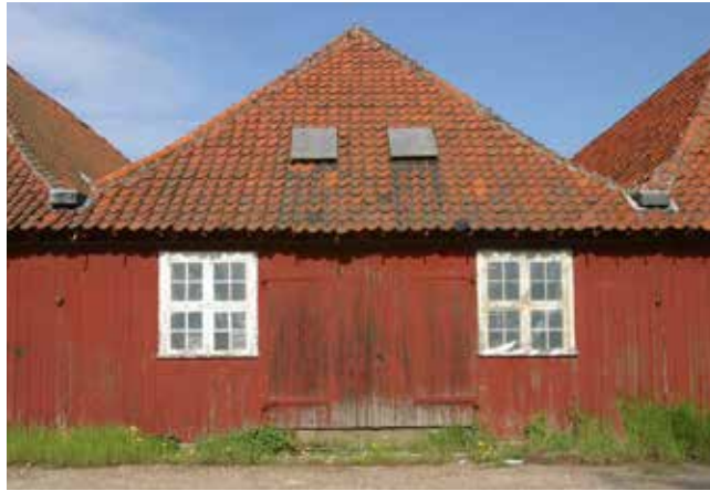
Gavl i østfacaden før restaureringen med nyere lodret brædebeklædning. Fotograf: Andreas Trier Mørch / Arkitekturbilleder.dk
