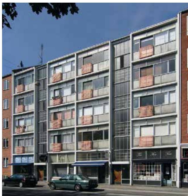
Arkitekt Mogens Lassen og ingeniør Ernst Ishøj opførte i Ordrup i 1937 det nu fredede fem etages hus, hvor skillevægge i beton, som noget nyt var bærende i konstruktionen. Huset kaldtes optimistisk Systemhuset, men der byggedes kun et (foto: Seier+Seier).
