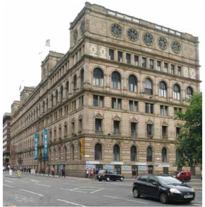
Manchester, Portland Street, S. og J. Watt's Warehouse fra 1851-56 tegnet af Travis og Mangnall. Foto CAJ 2010 og plan (modstående side) efter Cooper fig. 172.
