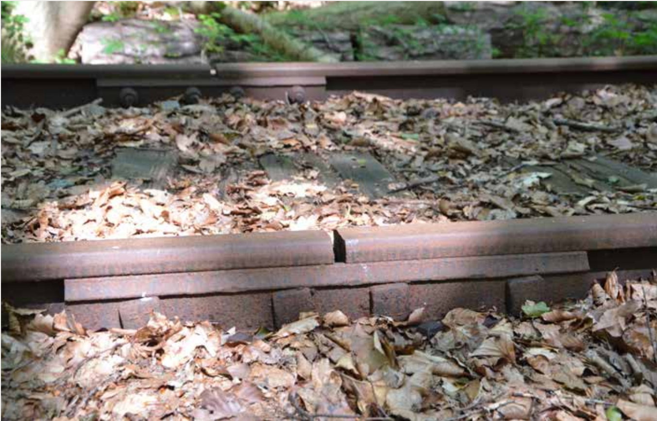
Skinnestød på Aabenraabanen hvor to jernbaneskinner er fastgjort til hinanden. De korte jernbanespor gav i ældre tid anledning til togenes karakteristiske gang i sporet, hvor den rejsende både mærkede og hørte når togets hjul passerede over skinnestødet. Foto: Lars Bjarke Christensen
