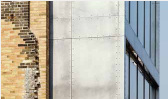
Fig. 18. Detalje af overgangen mellem Drejerværkstedets tidligere østgavl og den nye påbyggede gavl. Foto: JHC 2023.
