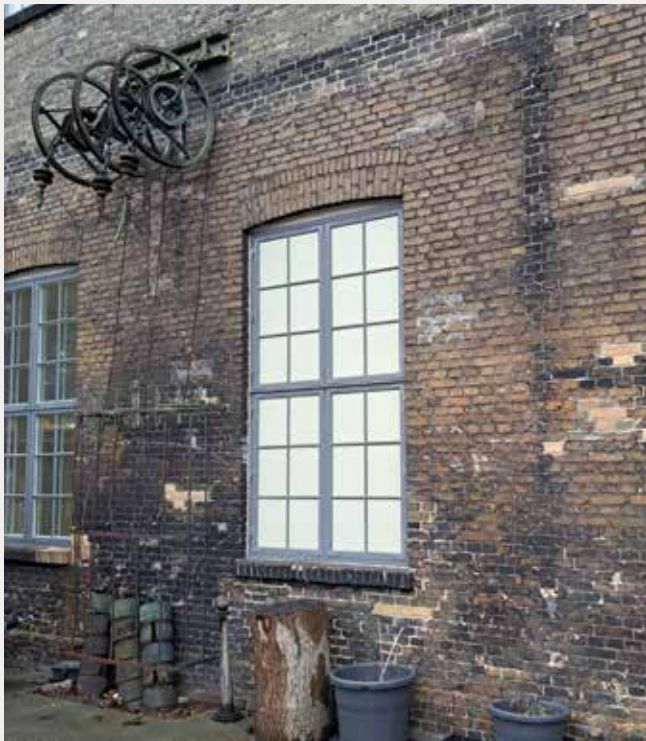
Fig. 25. Rester af gamle tovspil på Drejerværkstedets gårdfacade. Foto: JHC 2023.
