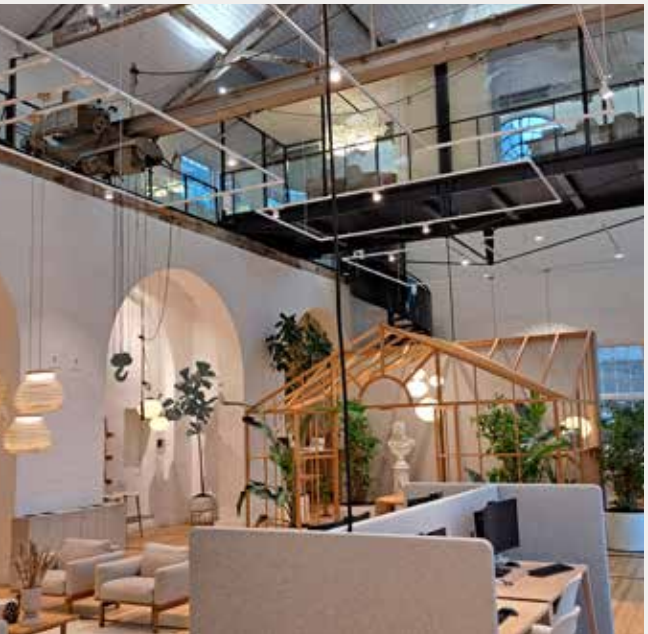
Fig. 17. Boogieværkstedet, det oprindelige lokomotivværksted fra 1862, nu indrettet til showroom for bolia.com. Bemærk traverskranen, der hviler på sin egen underkonstruktion af murede buer. Foto: JHC 2023.
